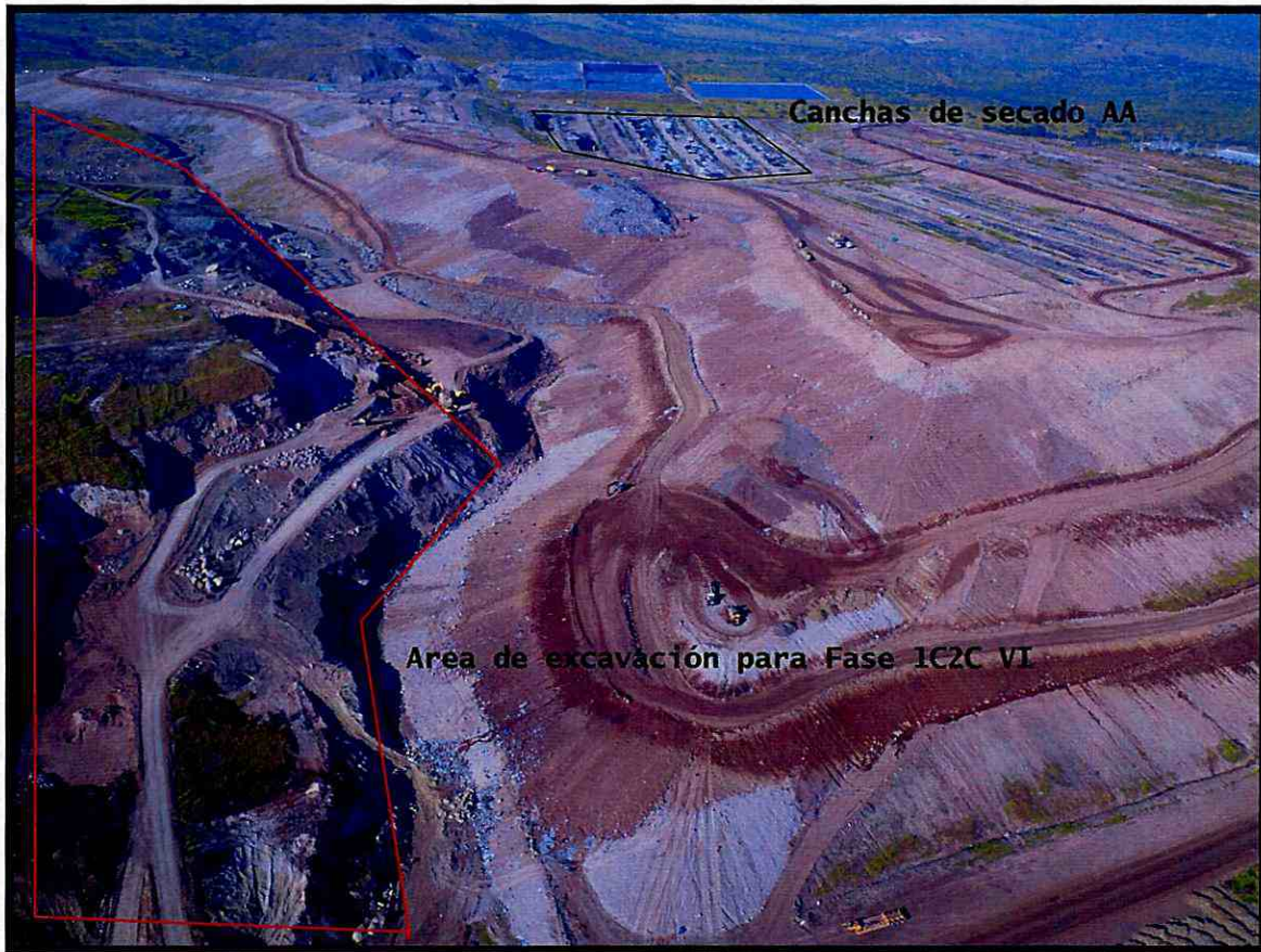
Fotografía 2: Área de excavación Fase 1C2C VI, programa para el 2020
