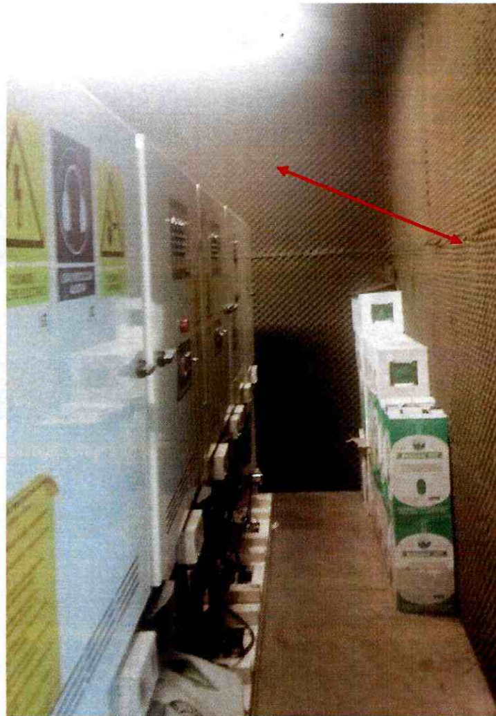
FOTOS DE AISLACIÓN DE SALA DE CENTRAL DE FRIO INTERIOR
