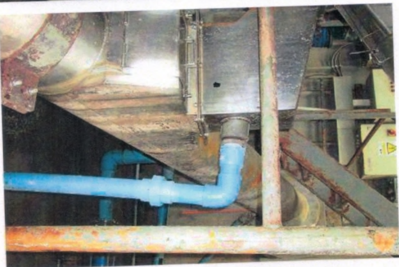
Figura 1C: Conexión tornillo estrujador, estanque acumulador
