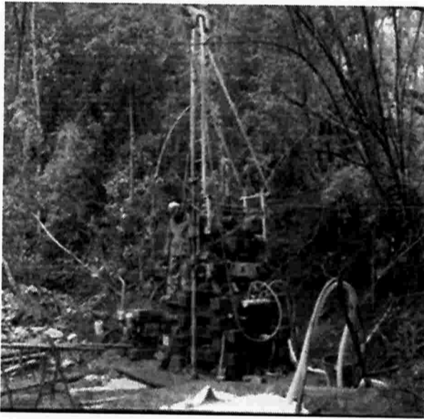
Fotografía 3: Sonda a utilizar para los sondajes SRT 01 y SRT 02.
