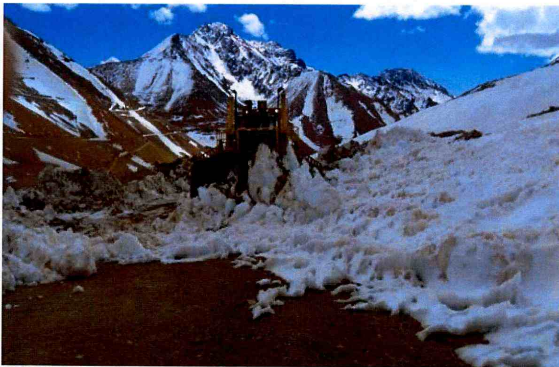
Ilustración 08: Despeje camino acceso a pozas Quebrada La Negra.
