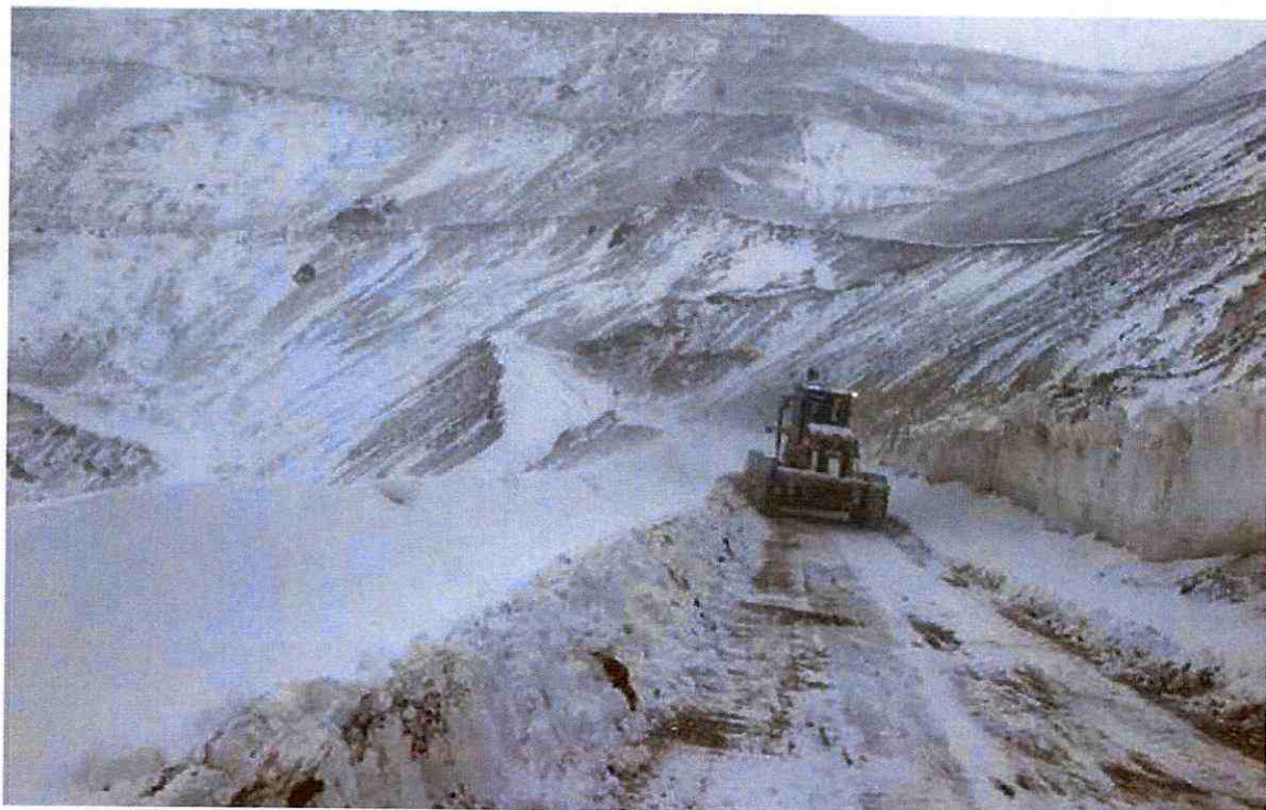
Ilustración 07: Trabajo de despeje y mantenimiento La Olla a Portezuelo
