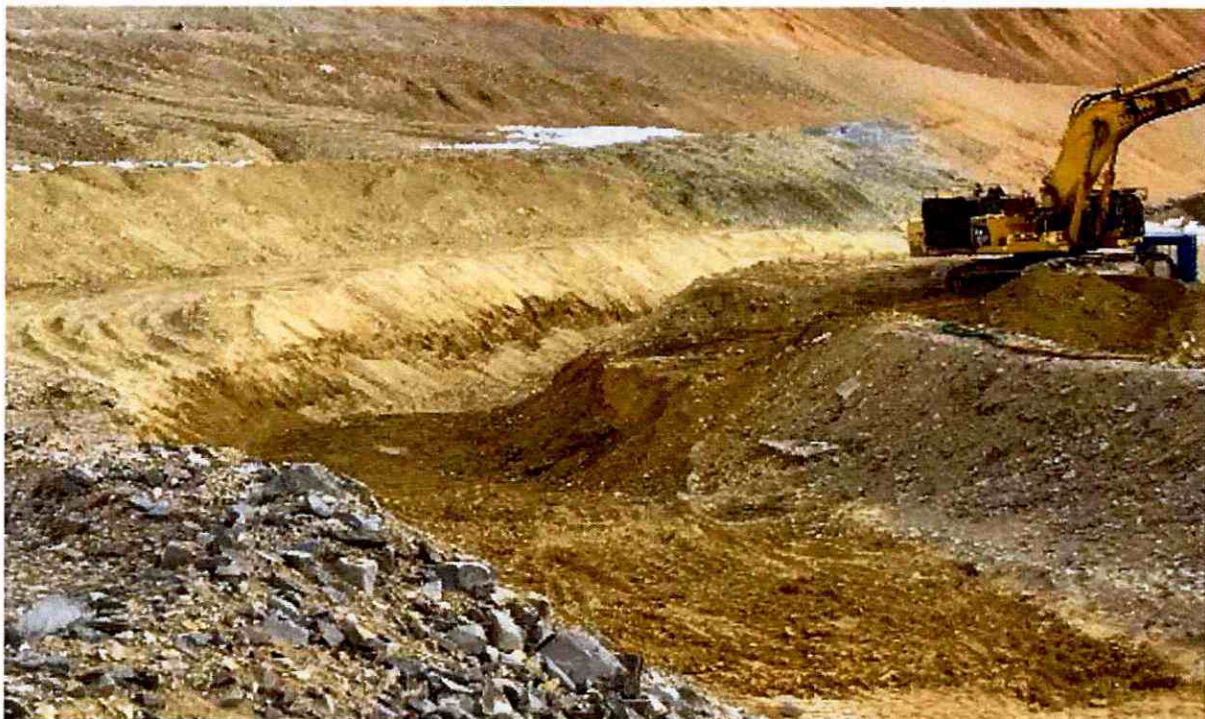
Ilustración 14: Despeje zanja pata botadero
