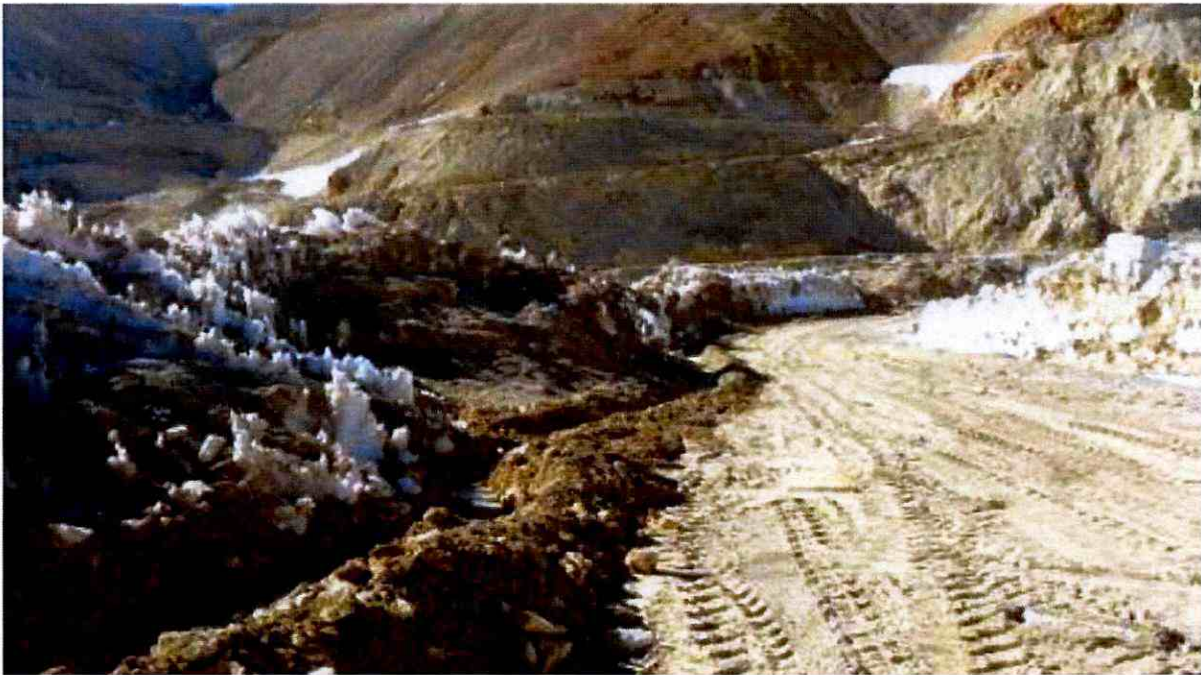
Ilustración 13: Canalización aguas de deshielos en área Botadero
