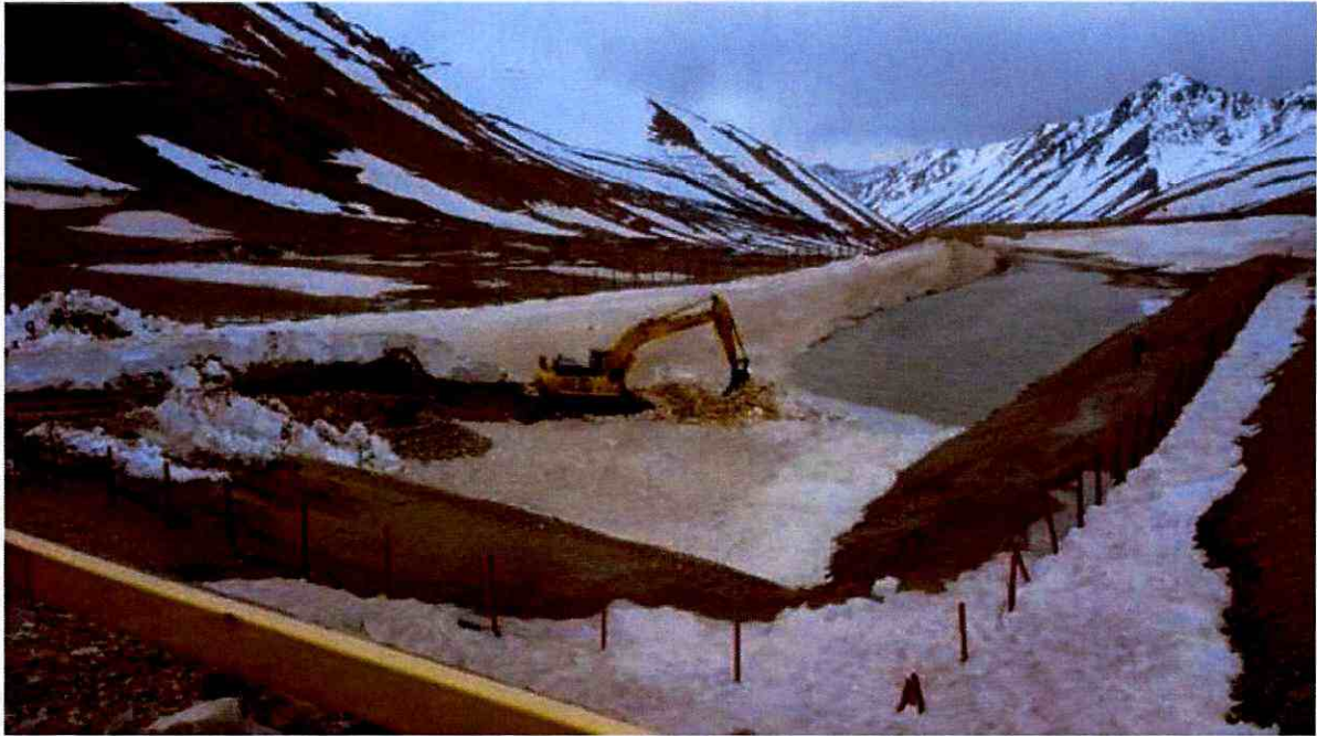
Ilustración 04: Retiro de nieve sedimentador Norte
