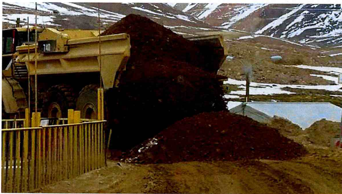
Ilustración 09 : Reposición de pretiles sector Campamento
