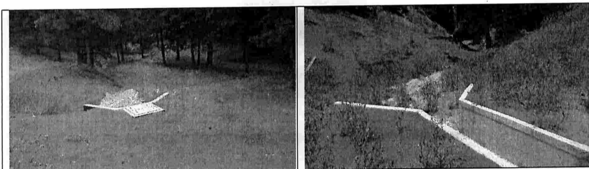
Foto 1 y 2. Obras para captar y conducir las aguas
