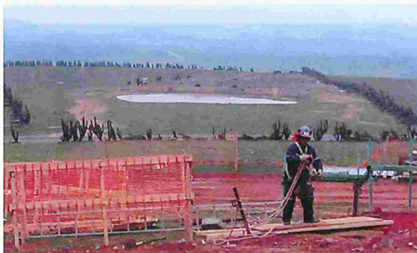
Instalación Torre Transmisión (T387),
