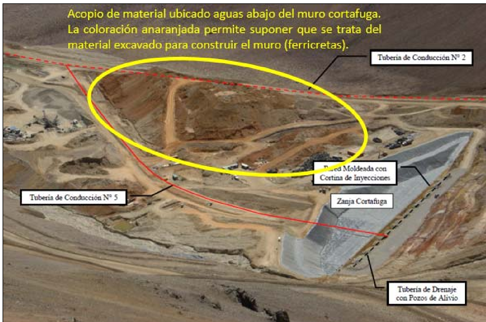
Figura 6. Acopio de material de excavación aguas abajo del muro cortafuga (Fuente: Foto 1 del “Documento C: Zanja Cortafuga y Tubería de Conducción N° 5”, adjunto a la presentación realizada por Compañía Minera Nevada con fecha 29/04/2013. Se agregó el círculo y el texto en amarillo).
