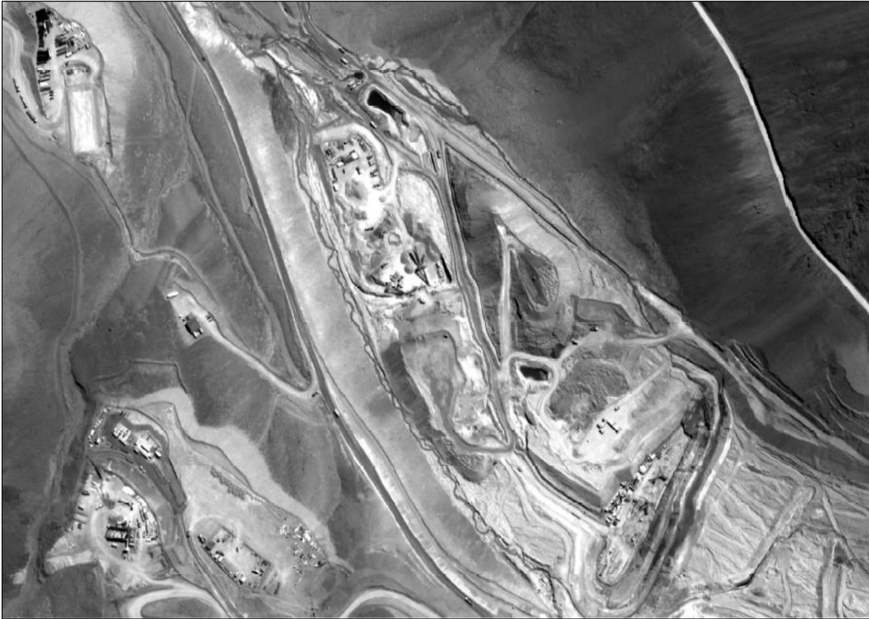
Figura 5. Situación de las nacientes del río Estrecho durante la construcción del sistema cortafuga (Fuente: Imagen del año 2011 WorldView-2 Banda Pancromática, 24 febrero)
