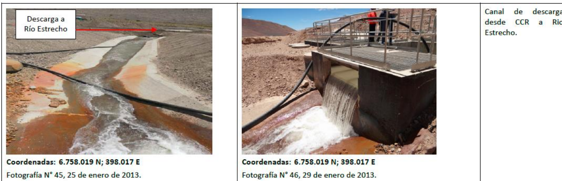
Figura 3. Descarga al río Estrecho desde la Cámara de Captación y Restitución (CCR) (Fuente: Informe DFZ-2013-63-III-RCA-IA).
