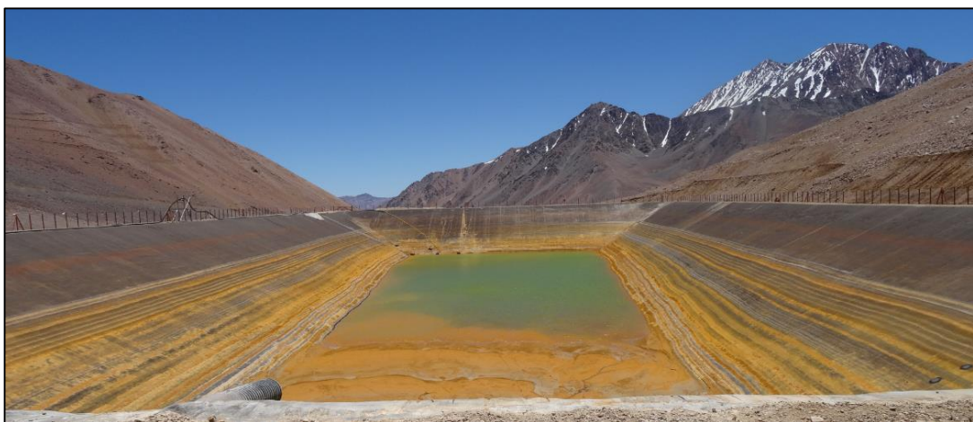
Fotografía 2. Se observa el interior de la piscina de acumulación N°1 en la cual se observa la ocurrencia de precipitación (fotografía capturada por funcionario de la SMA, 20 de enero de 2016).
