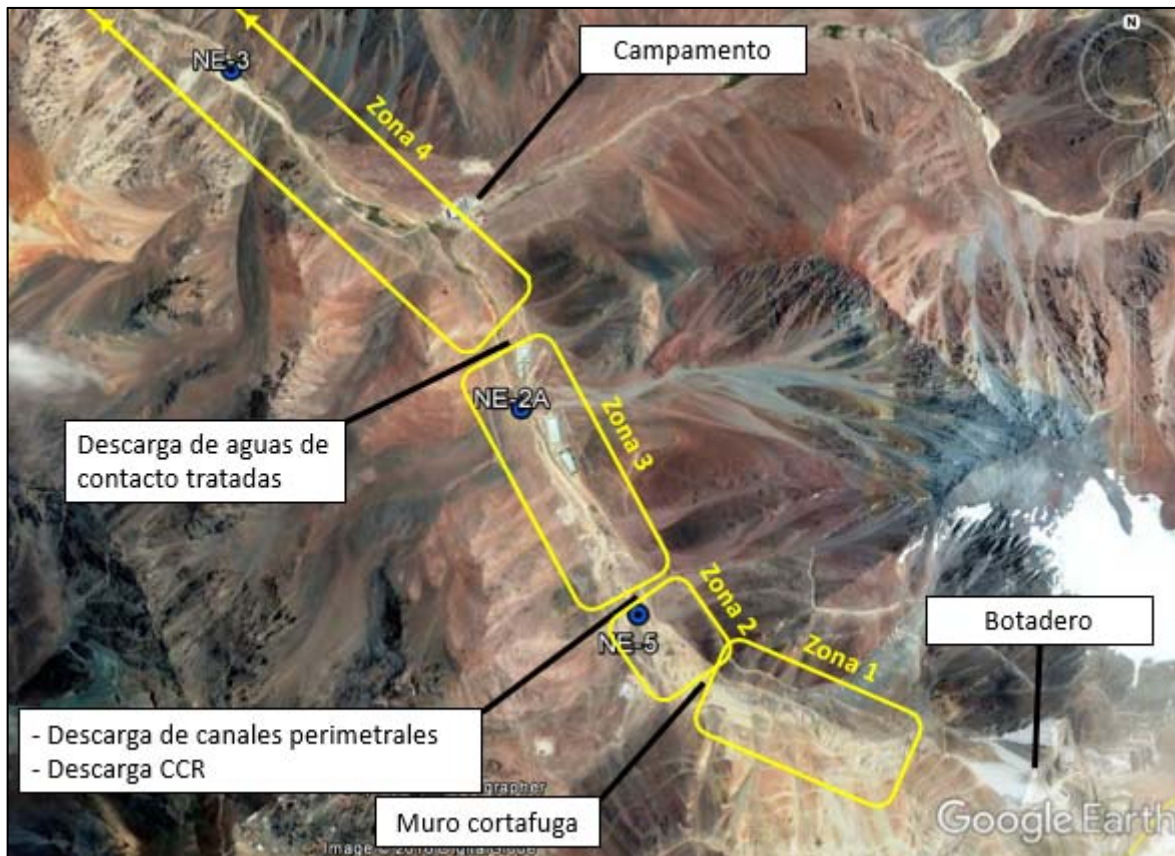
Figura 13. Zonificación de la parte alta del río Estrecho en función del efecto introducido por las obras más importantes del sistema de manejo de aguas.
