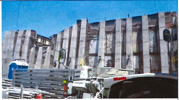
Muro preexistente de 12 (m) de altura ubicado en el sector poniente el cual es considerado como barrera acústica.
