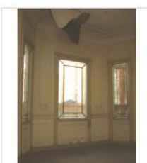
Desprendimiento terminación de pintura en cielo.
