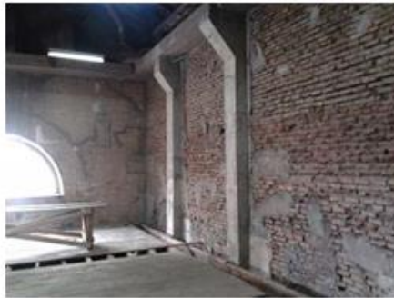
Refuerzos de hormigón en pilares y vigas. También se refuerzan vanos.
