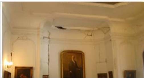
Fisuras y desprendimiento de estuco en salón suroriente
