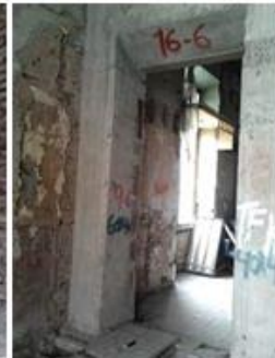
Refuerzos de hormigón en pilares y vigas. También se refuerzan vanos.
