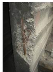
Desprendimientos de material. 1º de ornamento en base de pilar de primer piso y 2º pérdida de hormigón en esquina, enfierradura a la vista.
