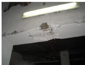
Desprendimiento de cemento en viga en el subterráneo.
