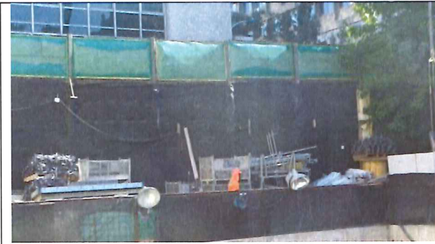
Cierre perimetral de paneles OSB de 4.8 (m) de altura cubierto con lana mineral en los límites sur y oriente.
