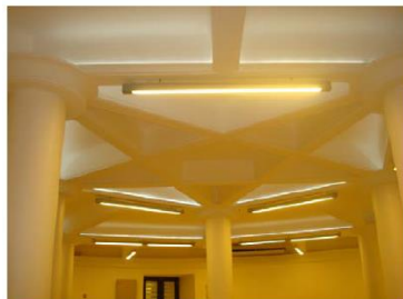
El subterráneo bajo la sala principal, estructura en base a pilares. Envidado radial, centro pentagonal.
