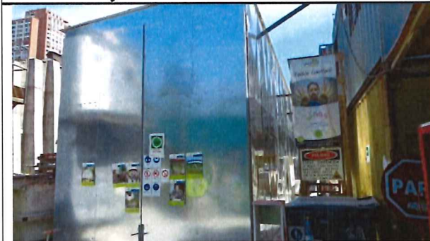
Túnel acústico construido con paneles OSB con lana mineral en su interior y recubierto por placas de acero de 1 [mm] de espesor.
