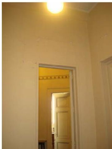
Daño superficial. Fisuras de estucos. En tercer piso, sector servicios.
