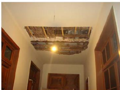
Pasillo en tercer piso, sector servicios con daños en cielo falso.
