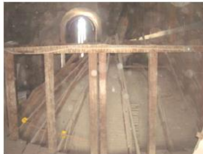
Cúpula estructura de madera, Entablillado madera y tierra original.
