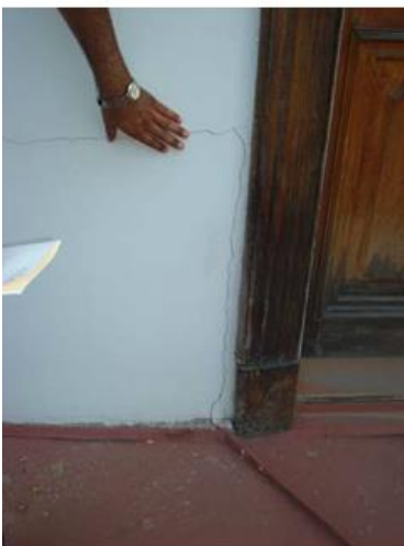
Detalle de estucos con fisuras por encuentro de materiales en fachada sur.
