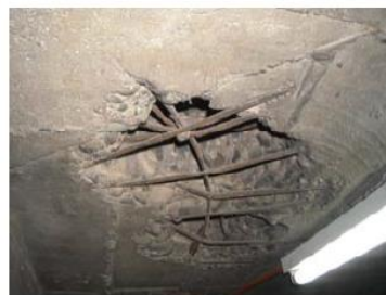
Perforación losa del túnel del tercer subterráneo
