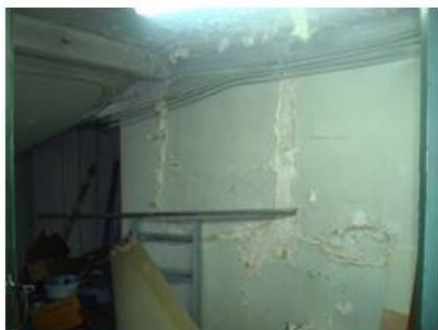
Humedad en subterráneo, por capilaridad desde calle La Bolsa.
