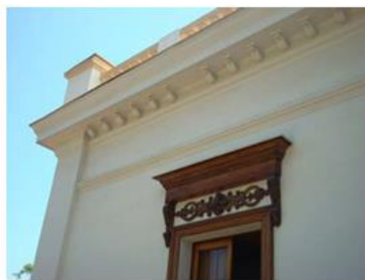
Detalle de fachada. Estucos y maderas en buen estado.
