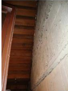
Muro medianero de hormigón armado en primer piso y primera mitad de segundo. Construcción posterior, que pudiera alterar rigidez de edificio existente.
