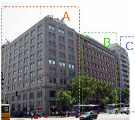
Vista esquina sur-poniente. Se observan tres cuerpos edificio, separados por juntas de dilatación.
