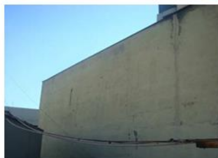
Fisuras de muro colindante al oriente.
