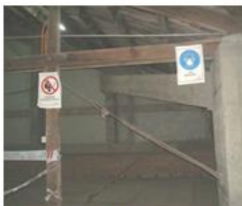
Entretecho. Cadena de coronamiento de hormigón sobre albañilería existente.
