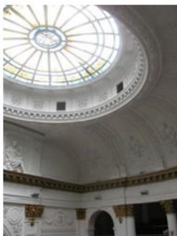
Vitrales con estructura metálica, bóveda de albañilería y madera y muros de albañilería.
