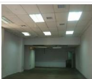
Incorporación de cielo falso y ventilación en el primer piso.
