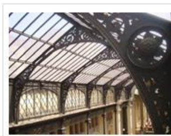
Estructura original en acero forjado.
