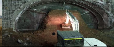
Inicio excavación Contra bóvedas 1 y 2 TIP
