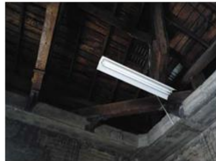
En sector sur poniente del segundo piso se realizan refuerzos de hormigón armado, con cadena superior en "L". Se afianza techumbre a nueva viga superior y se utilizan elementos metálicos para asegurar su continuidad y para reforzar la techumbre de madera.
