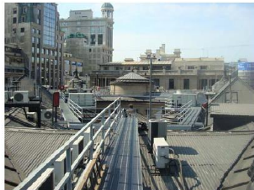
La cubierta, sometida a alteraciones con la aparición de las instalaciones de ventilación y con los trazados necesarios para la circulación con fines de mantenimiento.
