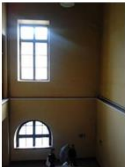
Imagen de fachada principal por interior, se observa paño en escalera, sin losa de arrioste entre los pisos.
