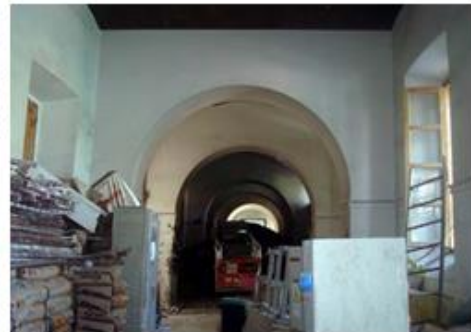
Imagen del pasillo perimetral. Se observa estructura de arcos de medio punto en albañilería.
