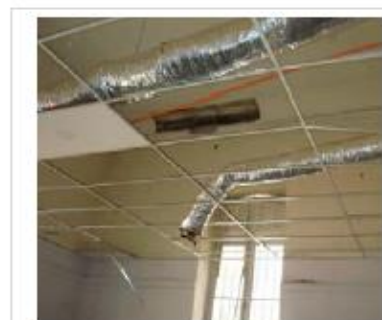
Incorporación de cielo falso y ventilación en el primer piso.
