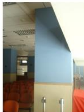
Pilares de espesor 80 x 80 cm en segundo piso
