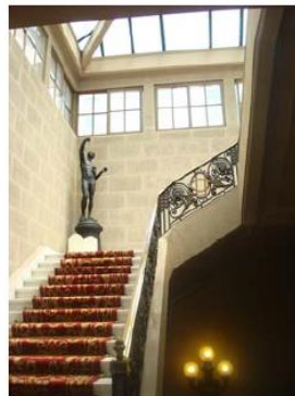
Vacío escalera y entrada de luz. Estructura metálica de lucarna.
