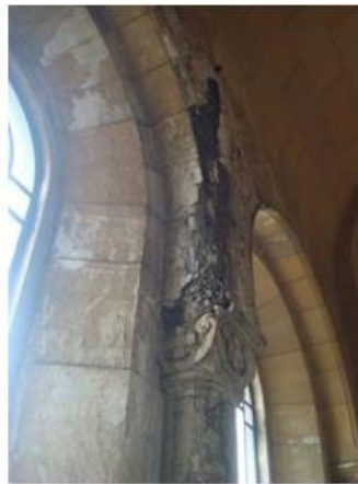
Desprendimientos de material. 1º de ornamento en base de pilar de primer piso y 2º pérdida de hormigón en esquina, enfierradura a la vista.
