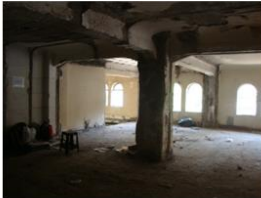
Segundo piso, despeje total de tabiques divisorios para remodelación.
