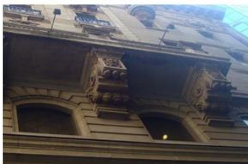
Daños de humedad en parte inferior de balcón por calle La Bolsa.
