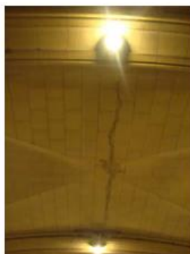
Grieta de estuco en capilla, se desarrolla por nave central, desde el altar a acceso, cortando en parte central los arcos de crucería. Sin análisis más específicos no es posible precisar si el daño afecta estructura de hormigón armado.
