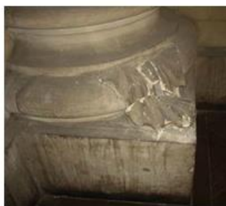
Desprendimientos de material. 1º de ornamento en base de pilar de primer piso y 2º pérdida de hormigón en esquina, enfierradura a la vista.
