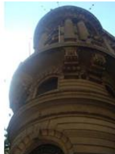
Estructura general, ritmo constante llenos y vacíos. Estructura hormigón con estucos decorativos.
