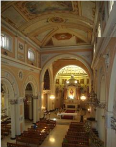
Imagen general interior. Nave central alta con 2 laterales más bajas. Tres pilares en cada lateral, refuerzo de muros con pilares.
