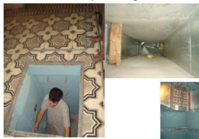
Subterráneo de ventilación de 2 m de profundidad en la zona norte del templo.
