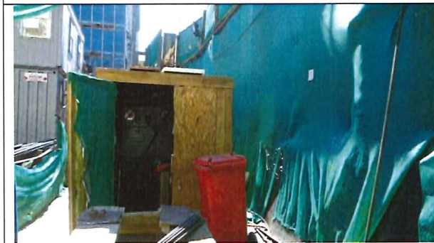
Taller de corte construido con paneles OSB y lana mineral en su interior.
