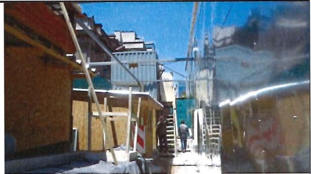
Container de 5 (m) de altura instalados en el sector oriente del proyecto, los cuales actúan como barreras acústicas a las emisiones de ruido generadas al interior del área de faenas.
