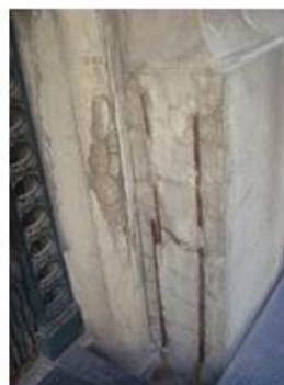
Daños en estucos de acceso calle La Bolsa. Se observa enfierradura.
