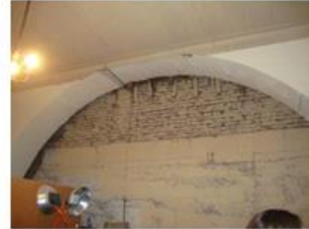
Muro medianero de hormigón armado en primer piso y primera mitad de segundo. Construcción posterior, que pudiera alterar rigidez de edificio existente.
