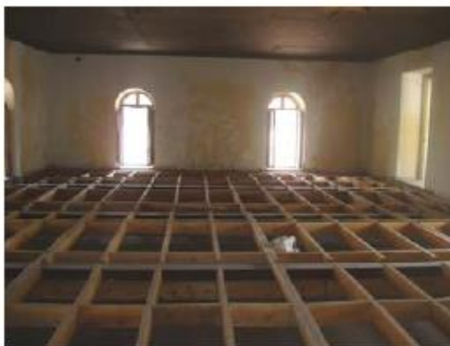
3° Piso. Incorporación de estructura de madera en piso sobre vigas metálicas instaladas en el año 1975.
