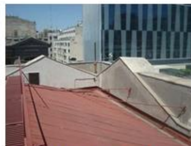
Techo, tensores metálicos para sostener cornisa (Foto esquina sur poniente).
