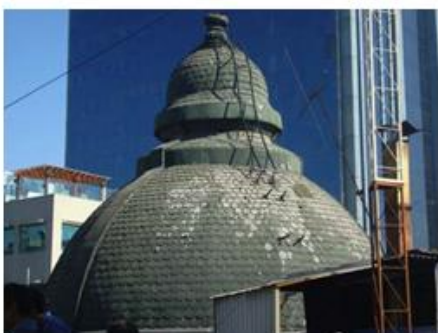
Daños superficiales en cúpula. Craquelamiento de pintura.
