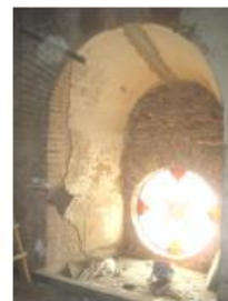
Entretecho muro oriente. Desmonte de estuco de tierra.
