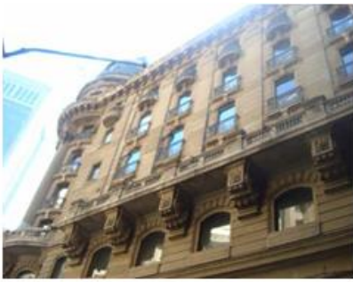
Estructura general, ritmo constante llenos y vacíos. Estructura hormigón con estucos decorativos.
