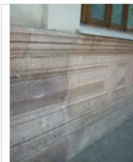
Reemplazo de mármol original en fachada.
