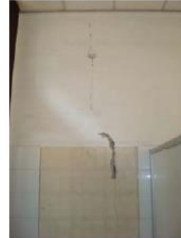
Daño estructural desde baño 2º piso a baño 1º piso.
