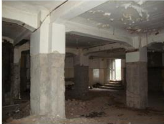
Subterráneo, estructura ortogonal de pilares y vigas de hormigón armado.
