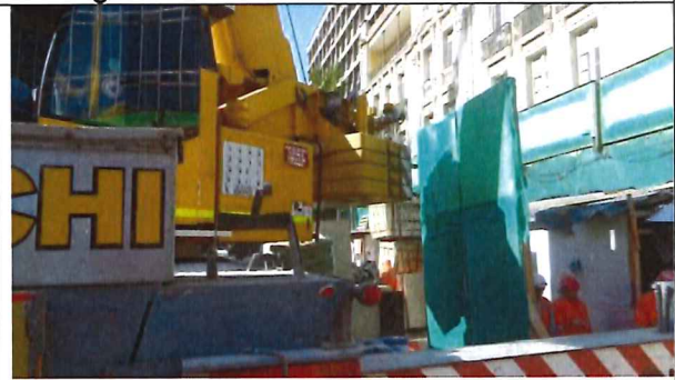
Barreras modulares de 3,6 [m] de altura construidas con paneles OSB y lana mineral.
