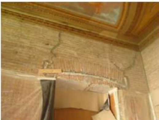
2° Piso, muros en nave poniente (capilla), Incorporación de estructura de acero (1895) en dintel de ladrillo, relleno de cemento en grietas.
