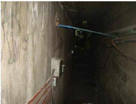
Tunel bajo vereda de Bandera. Buen estado, pequeñas manchas de humedad superficial.
