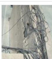
Estructura de hormigón en techo, con fisuras y desprendimiento de material.
