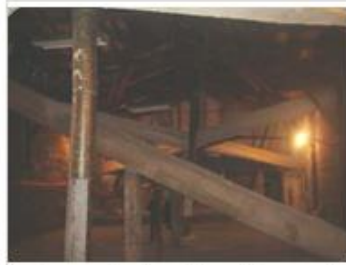
Refuerzo estructura de hormigón armado en entretecho del edificio.
