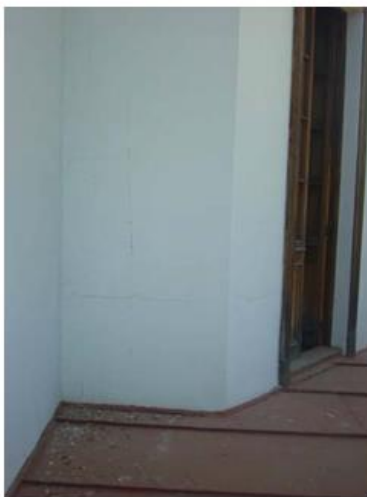
Detalle de estucos con fisuras por encuentro de materiales en fachada sur.
