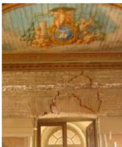
Recintos cuerpo poniente del edificio. Grietas estructurales en reparación.
