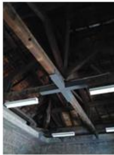
En sector sur poniente del segundo piso se realizan refuerzos de hormigón armado, con cadena superior en "L". Se afianza techumbre a nueva viga superior y se utilizan elementos metálicos para asegurar su continuidad y para reforzar la techumbre de madera.
