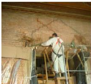
Recintos cuerpo poniente del edificio. Grietas estructurales en reparación.
