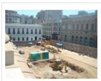
Construcción de estacionamiento subterráneo, frente fachada norte del edificio.
