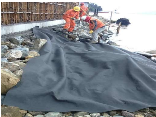
Imagen 19. NCA 1 proceso de colocación de geotextil.
