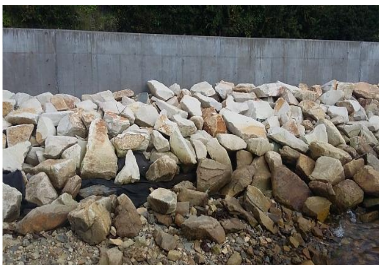
Imagen 7. Observación actual de enrocado sobre NCA-1, se aprecia capa de geotextil.
