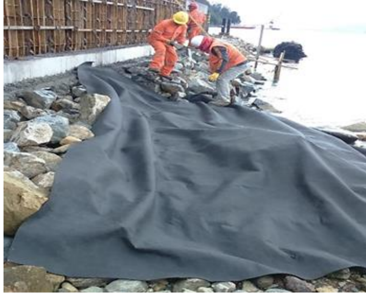
Imagen 4. Disposición de capa de geotextil sobre NCA-1.
