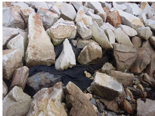
Imagen 20. NCA 1 proceso de colocación de geotextil.
