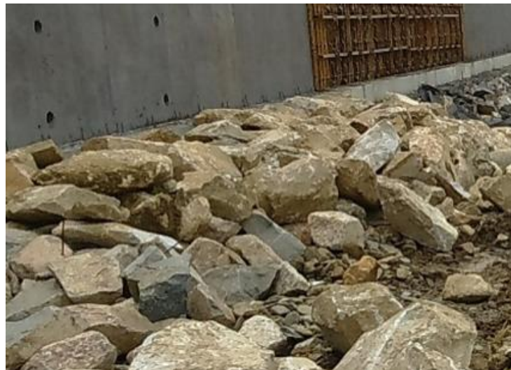
Imagen 5. Procedimiento final de sellado con roca sobre NCA-1.
