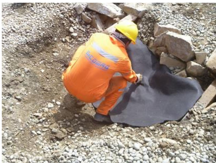
Imagen 15. Proceso de sellado con capa de geotextil sobre NCA-3.
