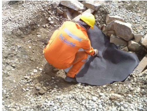
Imagen 26. NCA 3 Cubierto con geotextil
