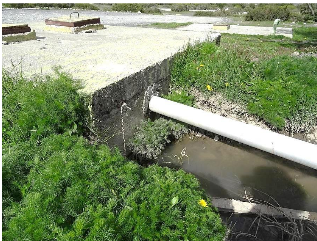
Imagen N° 2: Detalle Zona de filtración en fosa séptica, Informe SMA
