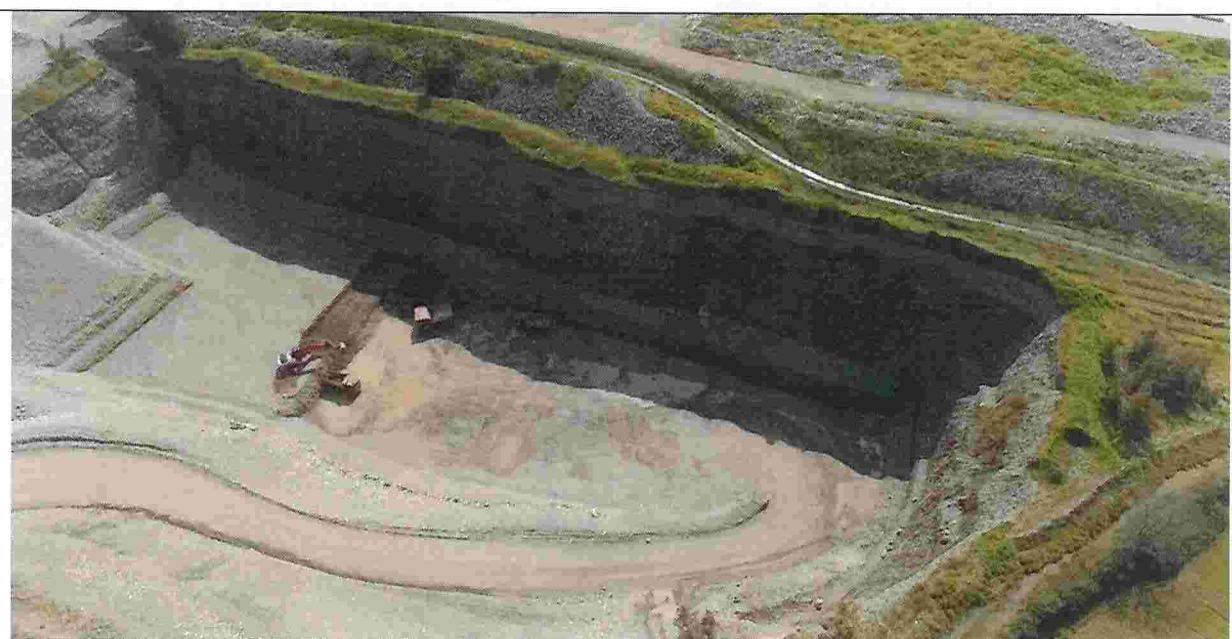
Imagen 6: máquina excavadora y camiones tolva ejecutando labores extractivas desde pozo lastrero
