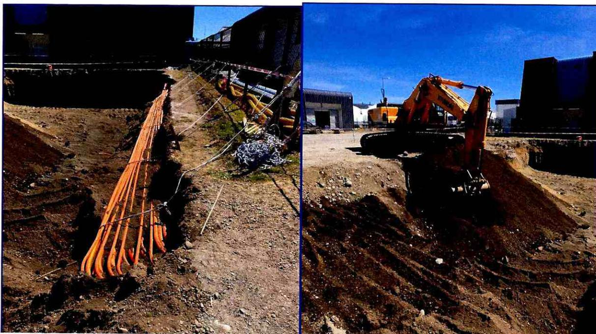
Fig. 4 y 5. Avance de excavaciones en segunda visita descubre redes eléctricas en porción norte del terreno a excavar.
