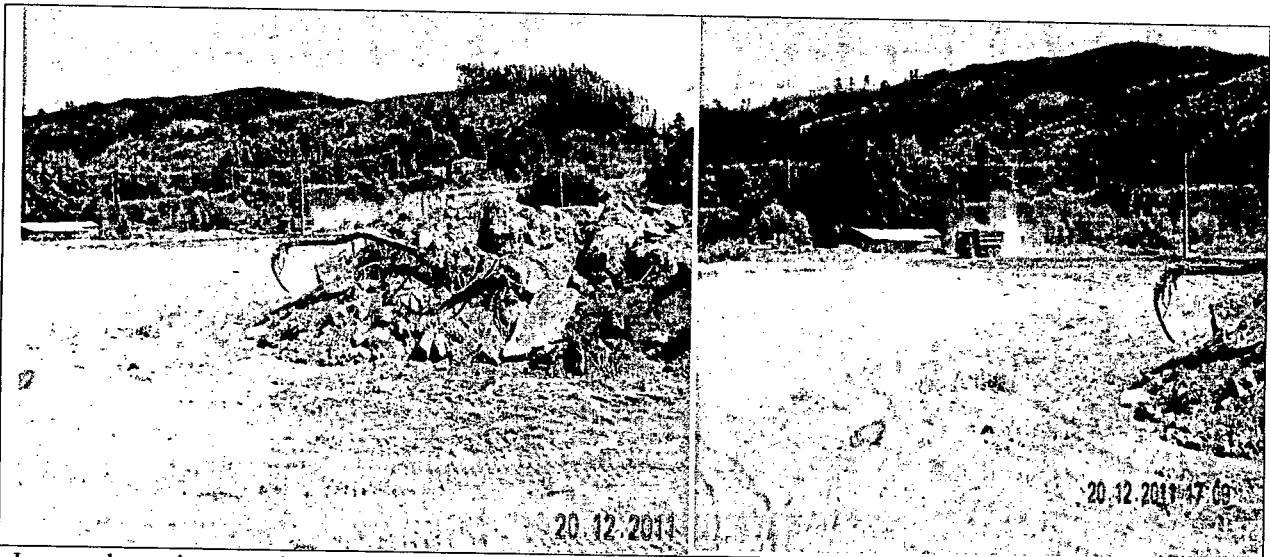
Ingreso de camiones, no hay control de acceso ni riego de aljibe.
