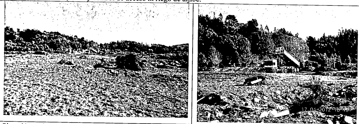
Situación en las mismas condiciones, 2012. Esto es previo al inicio de trabajos de la Construcción de la Autopista, que comenzaron durante el año 2013.
