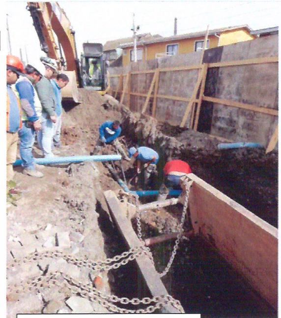
Modificación de Colector de Essbio para pasada de colector de aguas servidas proyectado.
