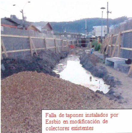
Falla de tapones instalados por Essbio en modificación de colectores existentes
