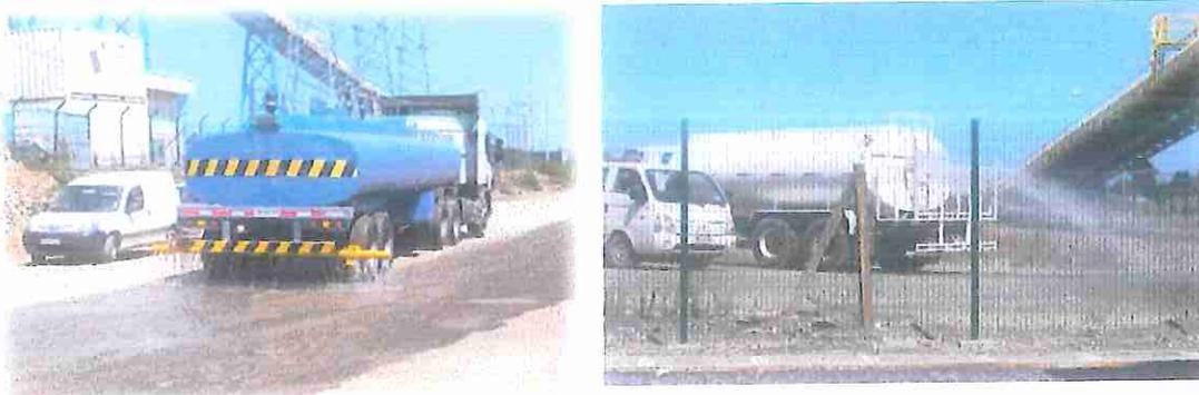
**Figura 1:** Camiones aljibe humectando los caminos durante la construcción de la Central.
