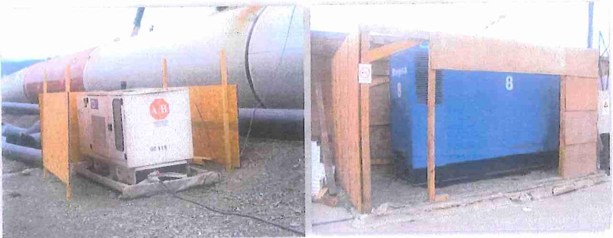
**Figura 4:** Medidas de mitigación implementadas durante la instalación de tuberías para disminuir el ruido en el sector de las viviendas adyacentes al Estero El Manco.
