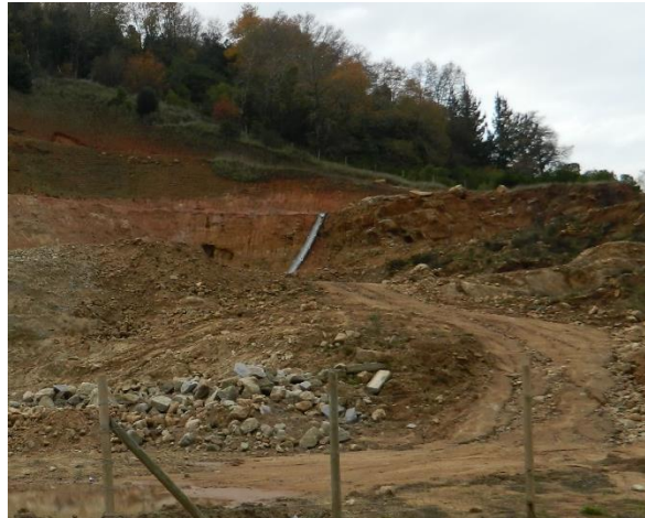
Figura 2. Obra de drenaje
