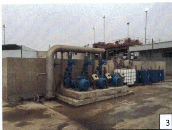
Imagen N° 3 y 4: Se puede evidenciar en estas imágenes que el área se encuentra ordenada y limpia. En la imagen N° 3 se encuentran los equipos para sanitizar el agua tratada, todos estos equipos están funcionando correctamente.
