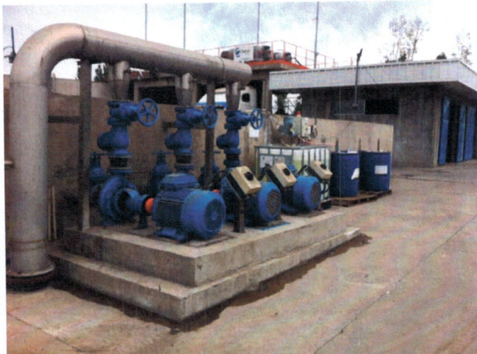
Imagen Nº 1: Estados de las bombas de liberación de ácido Peracético e Hipoclorito de Sodio en óptimas condiciones, además de los motores de recirculación.
