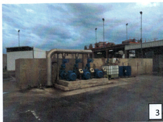
Imagen Nº 3 y 4: Se puede evidenciar en estas imágenes que el área se encuentra en orden. En la imagen Nº 3, que es donde se encuentran los equipos para sanitizar el agua tratada, todos estos equipos están funcionando correctamente (equipo de cloración y de ácido peracético).
