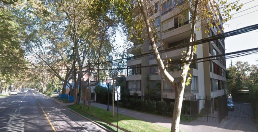
Figura 2 Edificio habitacional receptora de emisión de ruido.
