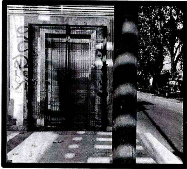
Ascensor lado oriente se encuentra cerrado
