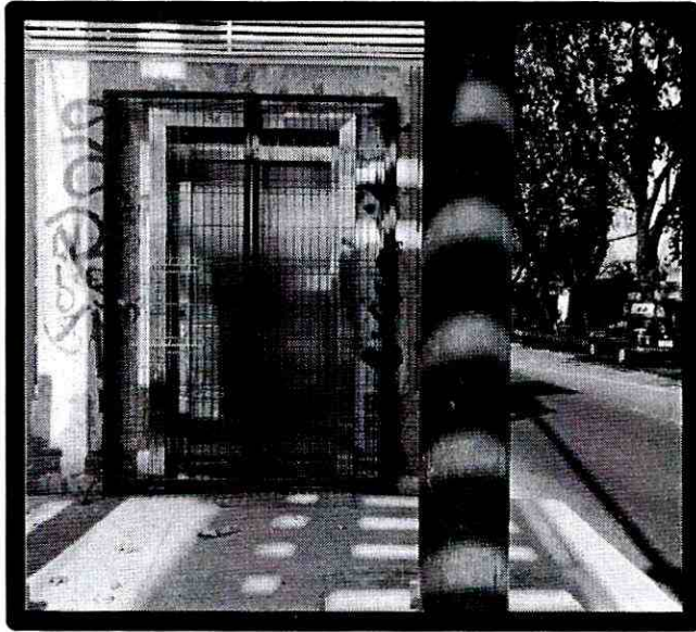
Ascensor lado oriente se encuentra cerrado
