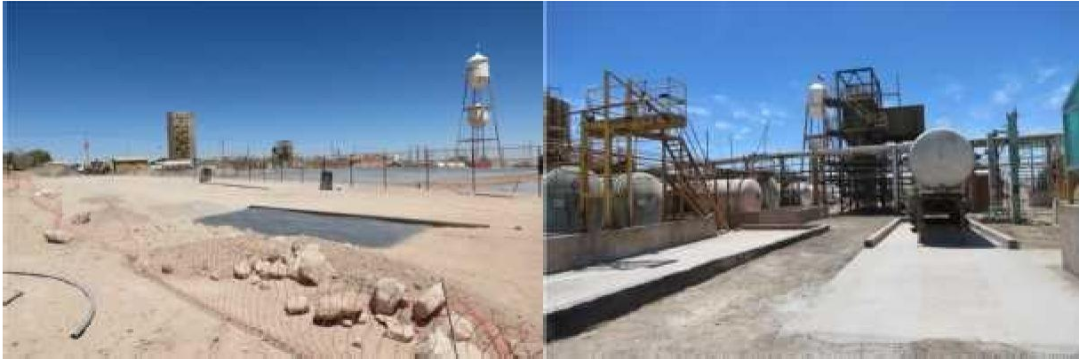
Fotografía 4-2. Vistas de zona industrial.
