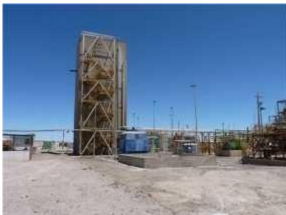
Fotografía 4-3: Vista de zona industrial.
