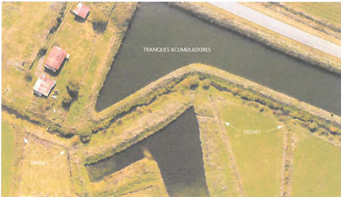
Figura 14: Sección del Estero Mulpulmo con drenes y tranques de acumulación de aguas entre E3 y E4 (5.508.635 N y 674.035 E, WGS84 H18)
