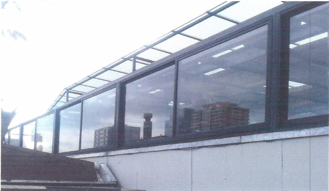
Ilustración 9: Montaje de ventanas corredizas sobre muro de deslinde. Imagen tomada desde propiedad familia Garfias, Junio 2018.
