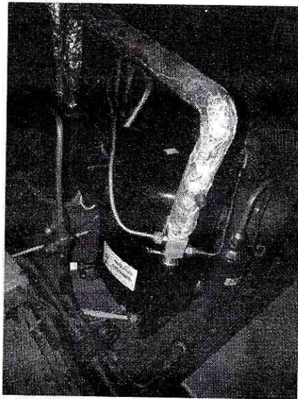
Figura 7: Compresor de cámara de frío ubicado en el segundo piso de las instalaciones de Hielo Cuber, de baja emisión de ruido, el cual reemplaza al anterior existente.
