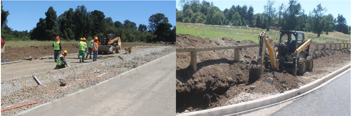
Imágenes 11 y 12. Frentes de trabajo activos en la construcción de caminos; pala mecánica retroexcavadora.
