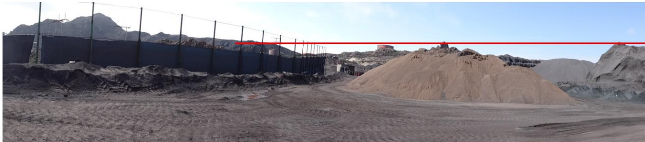
Figura 5-32: Acopios en cancha que superan la altura de la malla de protección eólica
