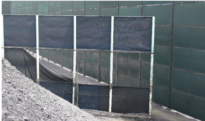
Figura 5-30: Paneles sin malla de protección, cancha de carbón.
