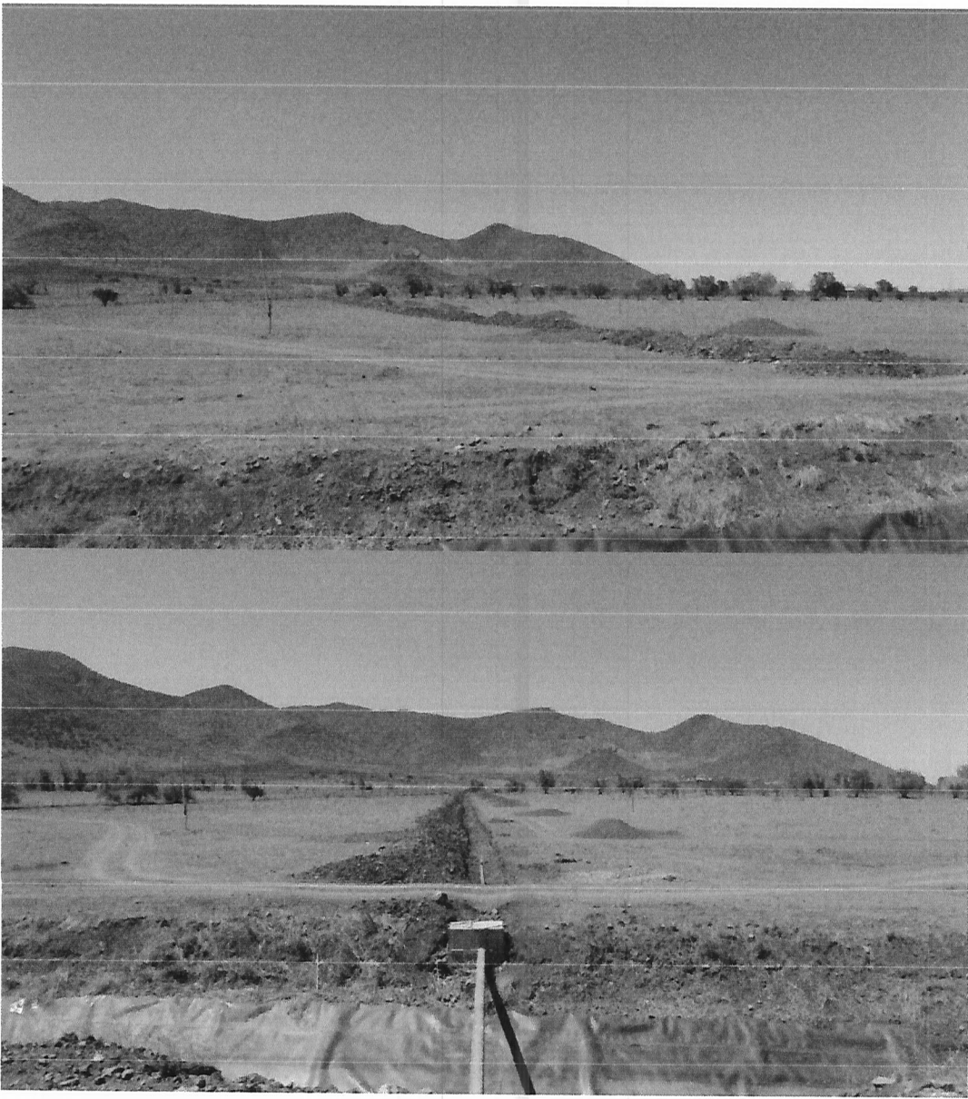
Imagen 30 y 31: Trazado tubería de impulsión a sector de faenas mineras.
