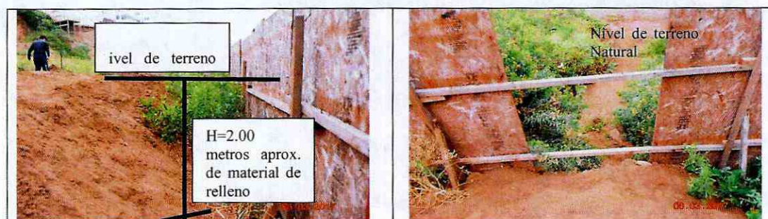
Figura N°3: Altura del relleno en zona del cierre perimetral.
