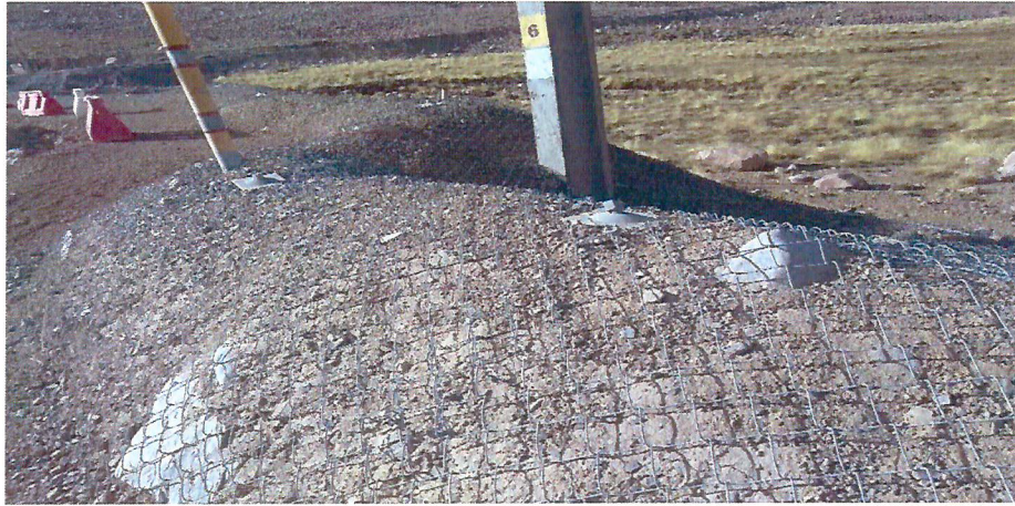
Malla MT-6000 cubriendo toda la longitud del pretil.
