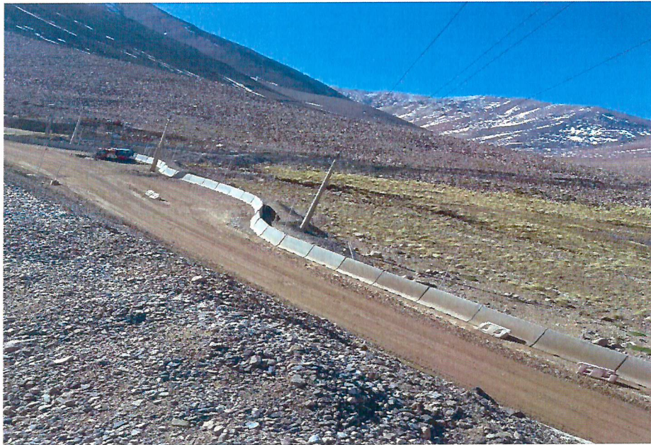
Imagen final de la instalación de barreras de hormigón
