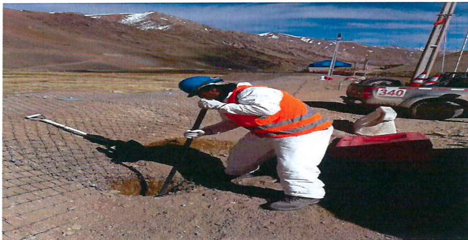
Excavación para instalar base del delineador.
