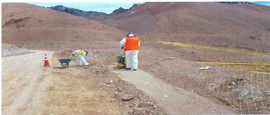
Compactación de vereda paralela al pretil.
