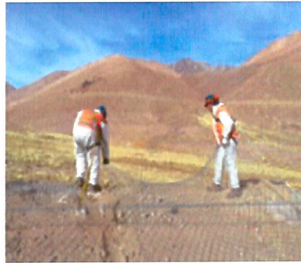
Instalación de malla MT-6000 sobre pretil y cubriendo el talud hacia la vega.
