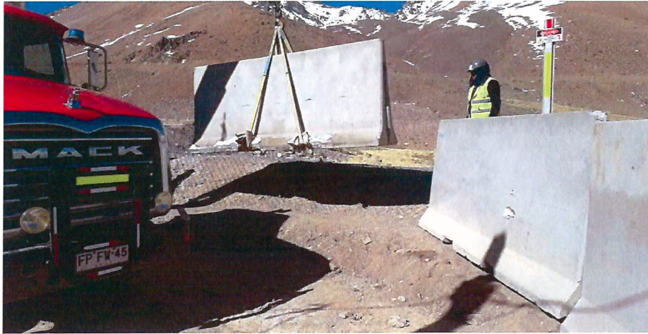
Instalación de barreras de hormigón sobre vereda.
