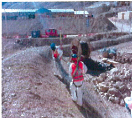
Instalación de malla MT-6000 sobre pretil y cubriendo el talud hacia la vega.
