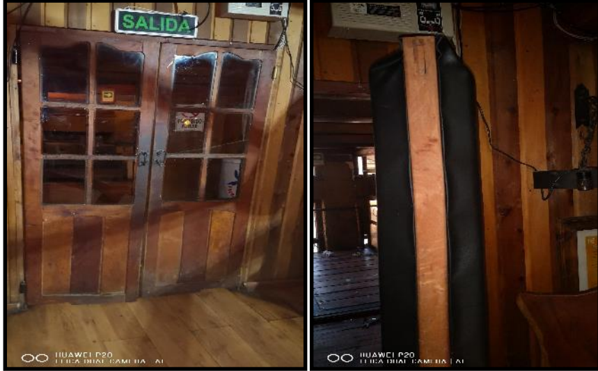
Imagen 4: Modificación e Instalación de Puerta Acústica Hall – Pista de Baile.
