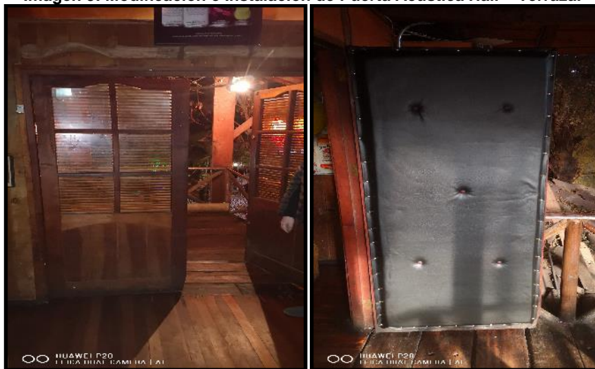
Imagen 5: Modificación e Instalación de Puerta Acústica Hall – Terraza.
