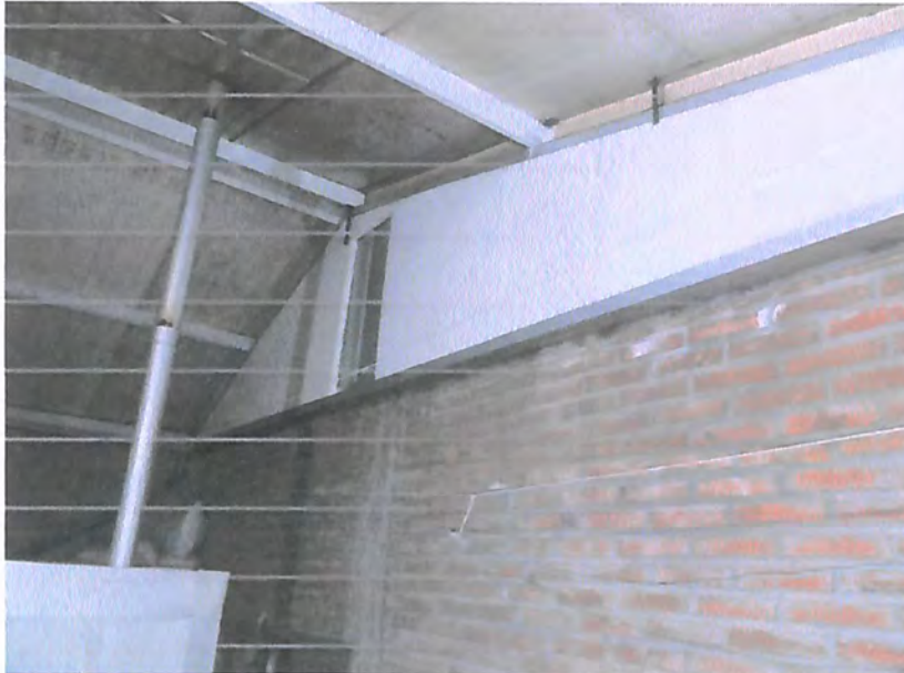
Figura 3. Planchas metálicas con isopol aumentando la altura de pared divisoria, conformando un cierre completo al llegar a techumbre.
