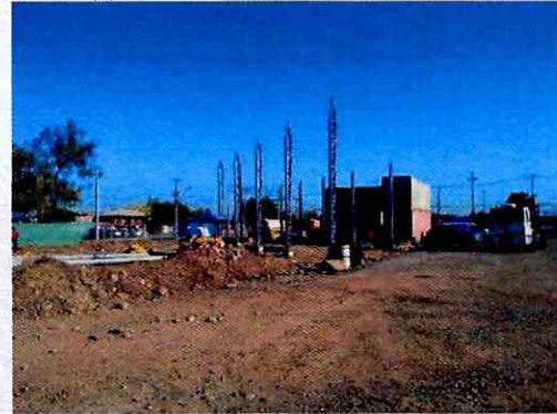
Faenas de construcción
