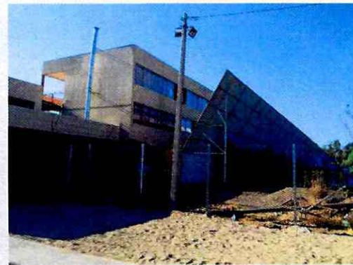
Pantalla acústica deslinde oriente
