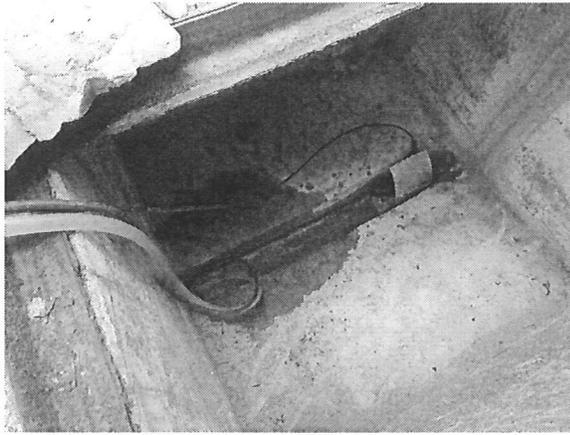
Imagen correspondiente a Informe de Fiscalización Ambiental, DFZ-2015-641-XII-RCA-IA, Fotografía 10, de fecha: 12-11-2015, cuya glosa señala "Descripción Medio de Prueba: Vista interior de última cámara de inspección del efluente de la Planta de Tratamiento de Aguas Servidas del Hotel Lago Grey. Se observa la instalación de sensores para la medición de pH, Temperatura y caudal (área-velocidad), además de flexible para la succión de las muestras de agua."
