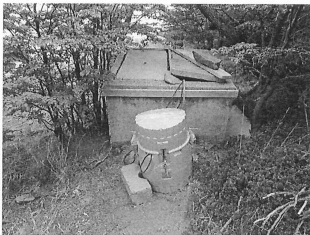
Imagen correspondiente a Informe de Fiscalización Ambiental, DFZ-2015-641-XII-RCA-IA, Fotografía 9, de fecha: 12-11-2015, cuya glosa señala "Descripción Medio de Prueba: Vista general de última cámara de inspección del efluente de la Planta de Tratamiento de Aguas Servidas del Hotel Lago Grey. Se observa adicionalmente la instalación en dicho lugar de un muestreador automático para la obtención de muestras del efluente final descargado al Río Grey."
