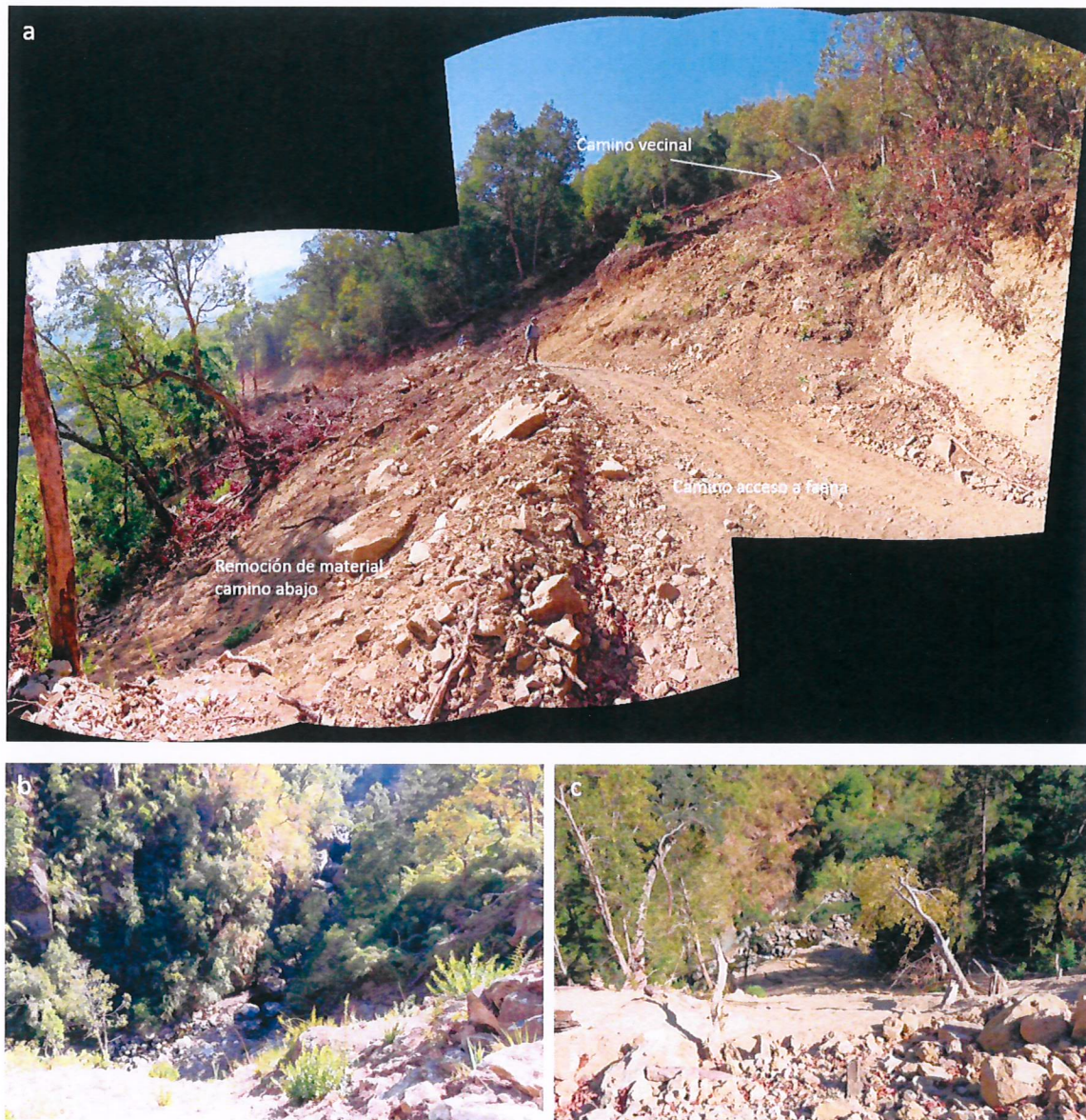
Figura 10. Fotografías de depósitos sobre el estero Nacimiento. Vista desde camino de acceso a faena. a) Se observa la remoción del material camino abajo (hacia el estero nacimiento), del deslizamiento de suelo desde el camino vecinal. b) Material removido hacia el estero Nacimiento. Se observan fragmentos de roca de gran tamaño (diámetro ~1-2 m) que han caído hacia el estero. c) Material clástico de tamaños variables que han alcanzado el cauce el estero Nacimiento. Se observan cárcavas en su parte baja, producto de la erosión del depósito y remoción del material fino.
