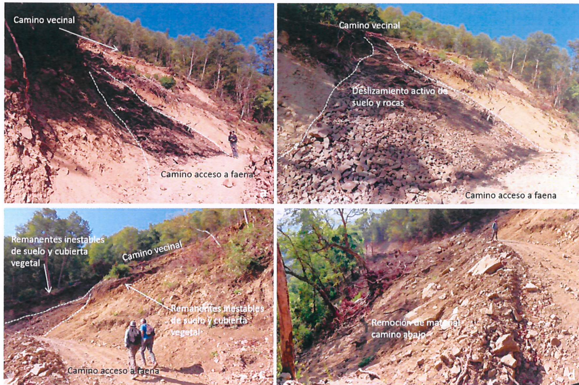
Figura 6: Remociones en masa por deslizamiento de suelo y rocas sobre camino de acceso a faena. Vista desde camino de acceso a faena.
