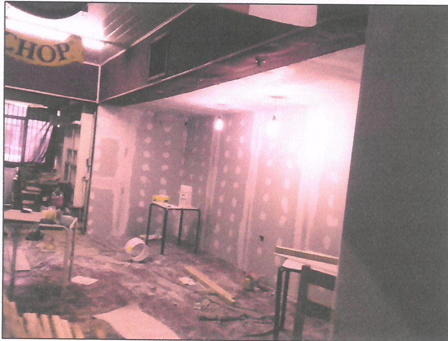
Enlucido de muro con encintado y empaste con yeso en juntas verticales y horizontales.
