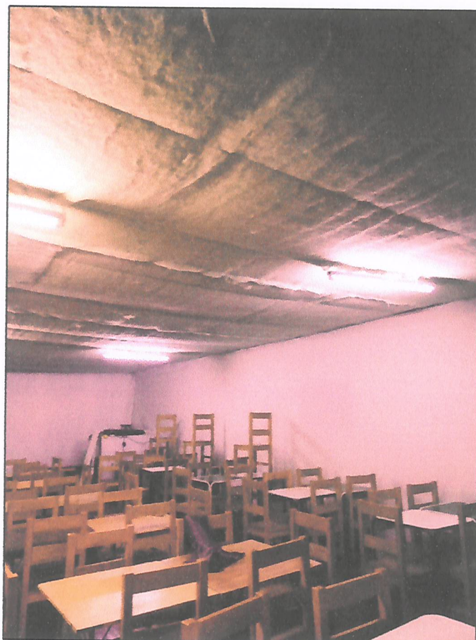
Cielo con Sistema acústico Politerm
