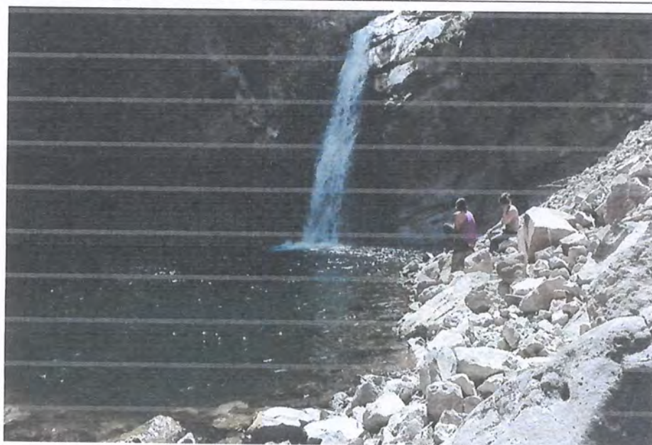
Fotografía verano 2019. Pozón con menos caudal y material que obstaculiza su libre escurrimiento.
