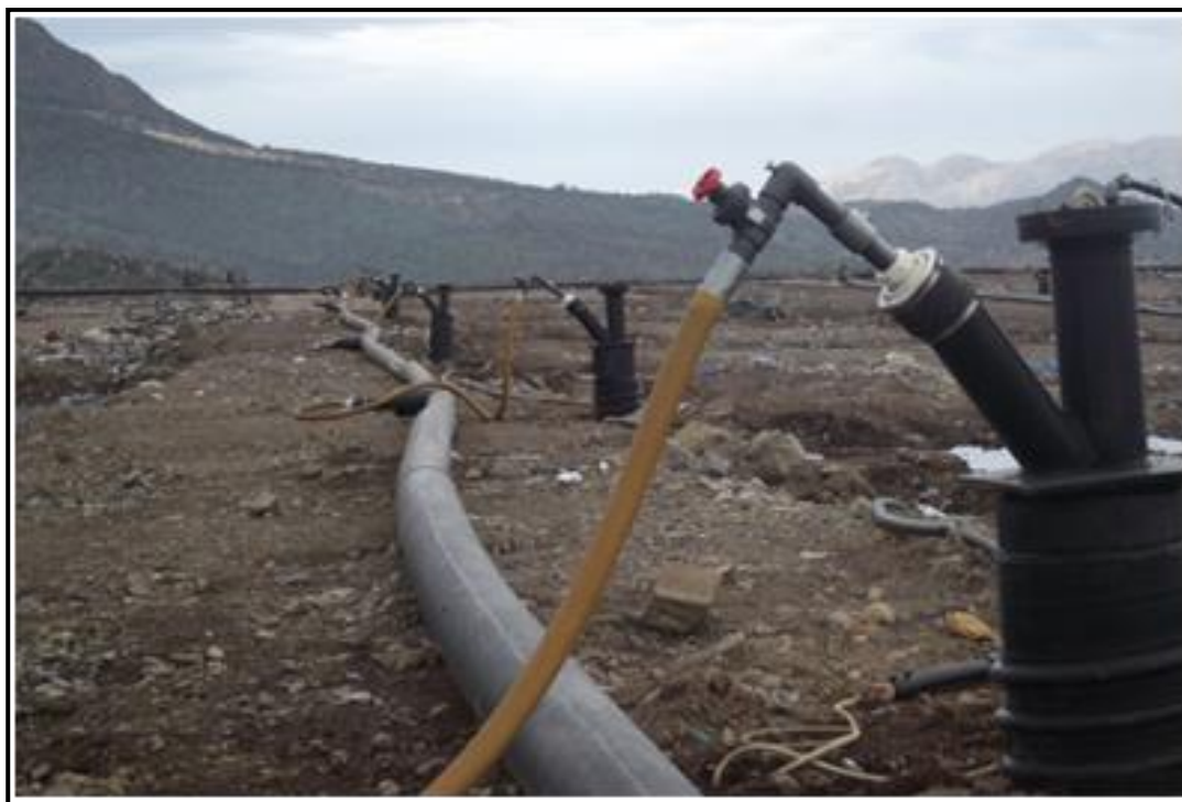
Figura 4 Vista General del Sistema de Extracción de Biogás en el Relleno Sanitario Loma Los Colorados.
