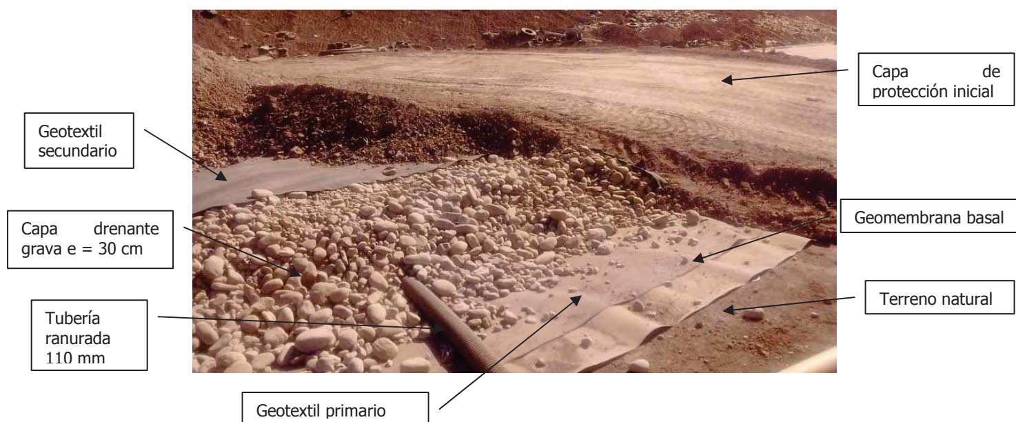
Figura 1. Imagen de construcción típica de la base impermeabilizada del RS
