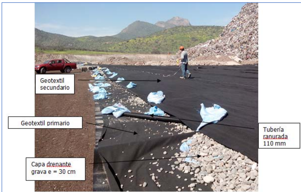
Imagen 4.2.2: Visualización de los componentes del sistema de impermeabilización.
