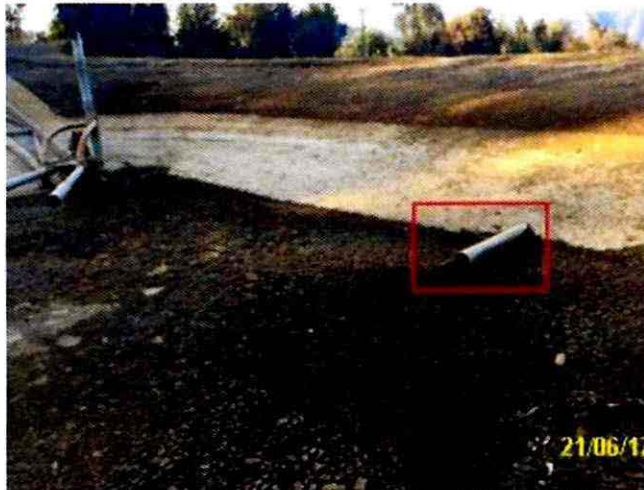
Fotografía 1 Fecha: 21 de junio de 2017 Coordenadas DATUM WGS84, Huso 19 Este: 292.701 m Norte: 6.380.220 m Descripción Medio de Prueba: Imagen en terreno de tubería de recirculación de aguas servidas en la piscina de regulación
