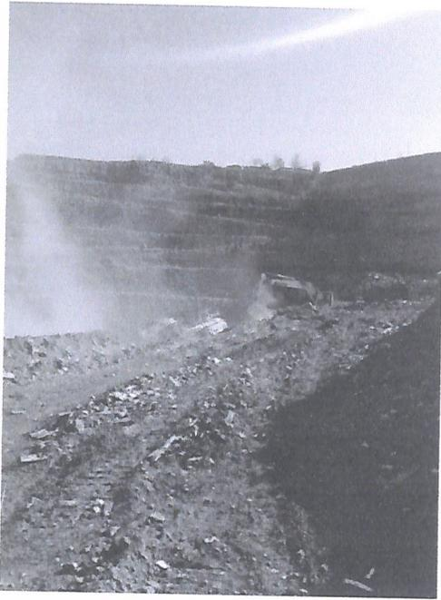
Maquinaria pesada en operación de remoción de materiales y despeje de focos. Con esta acción aumenta la emisión de la mezcla de humos y vapor.
