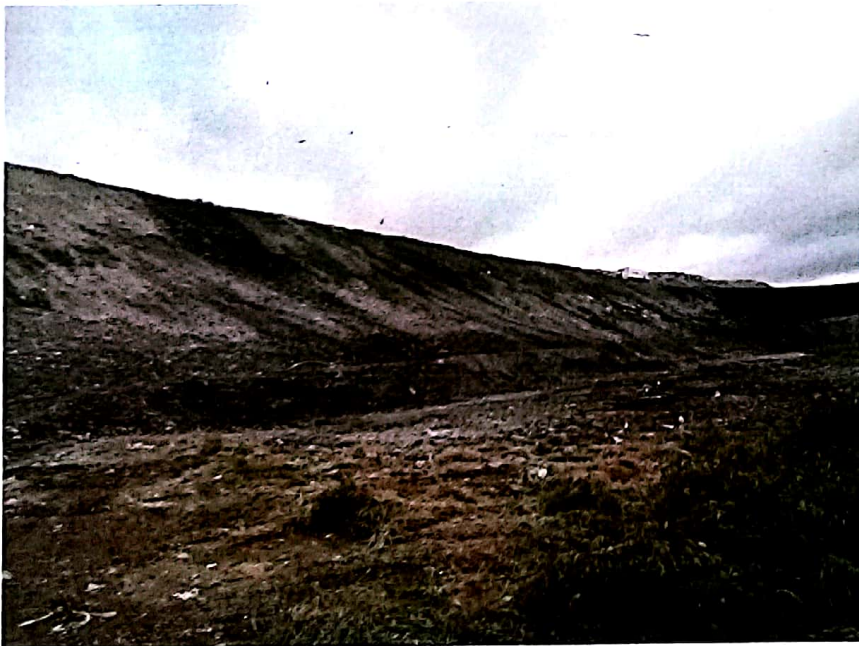
Fotografía 2 Estado Actual talud,
