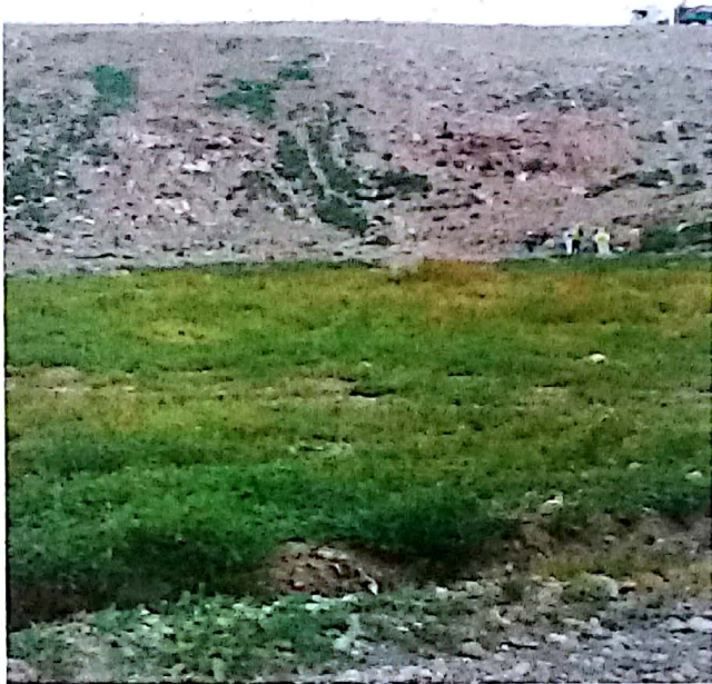
Fotografía 10: zona de taludes con basura descubierta.
