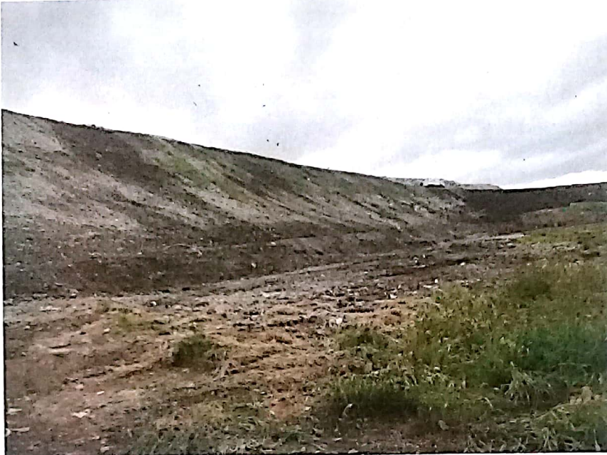
Fotografía 3 Estado Actual talud,
