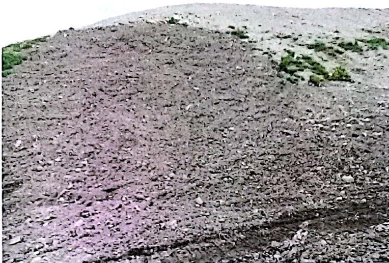
Fotografía 1 Estado Actual talud,
