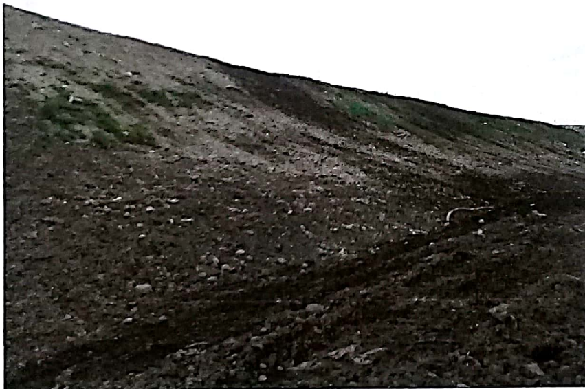
Fotografía 4 Estado Actual talud,
