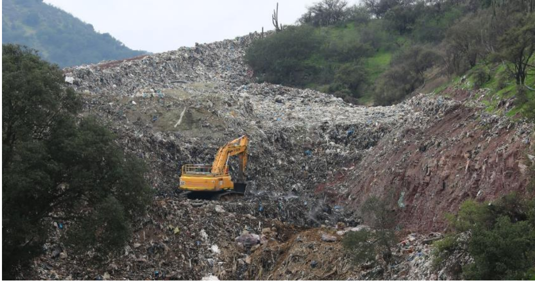
Fotografía 5 – Operación con Maquinaria en Sector Bajo de la Quebrada El Boldal (Sector 2).
