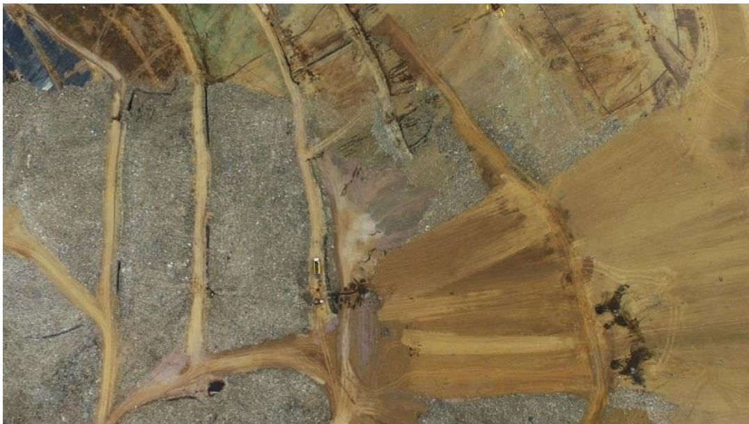
Fotografía 3 – Zona de Reacomodo y Cobertura Temporal de Residuos (Sector 4).
