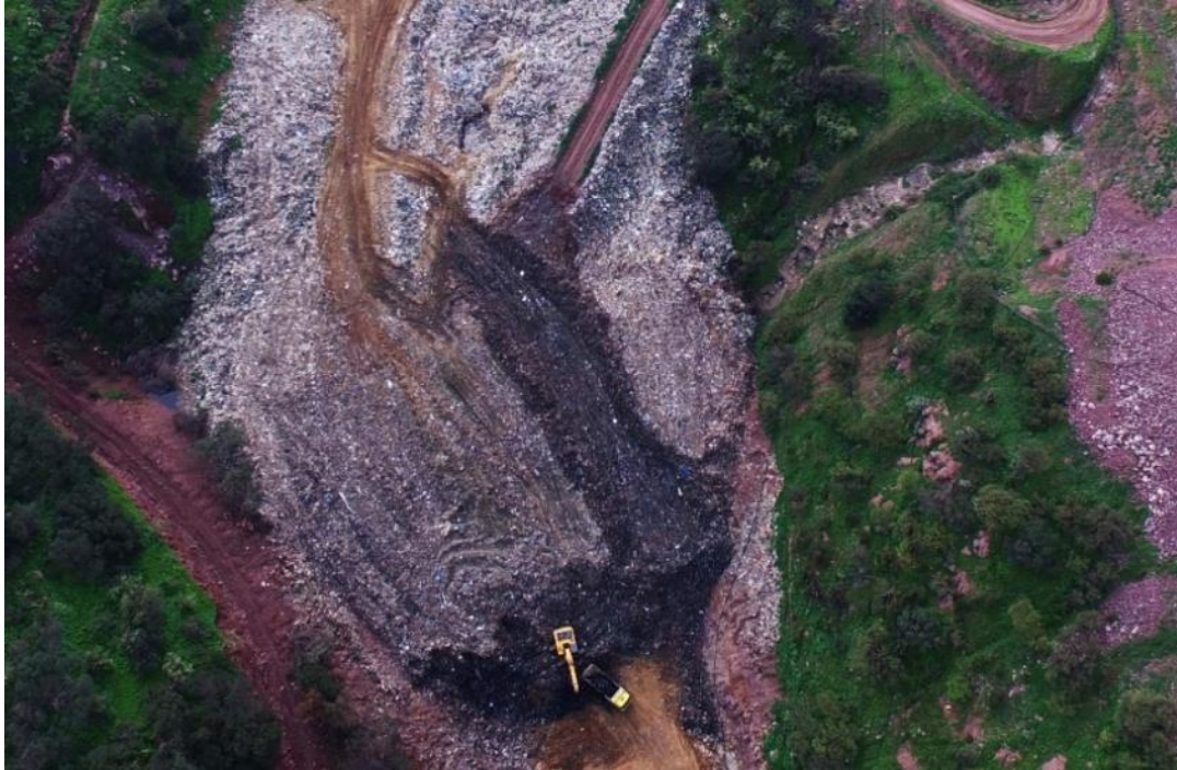
Fotografía 4 – Sector Bajo de la Quebrada El Boldal (Sector 1).
