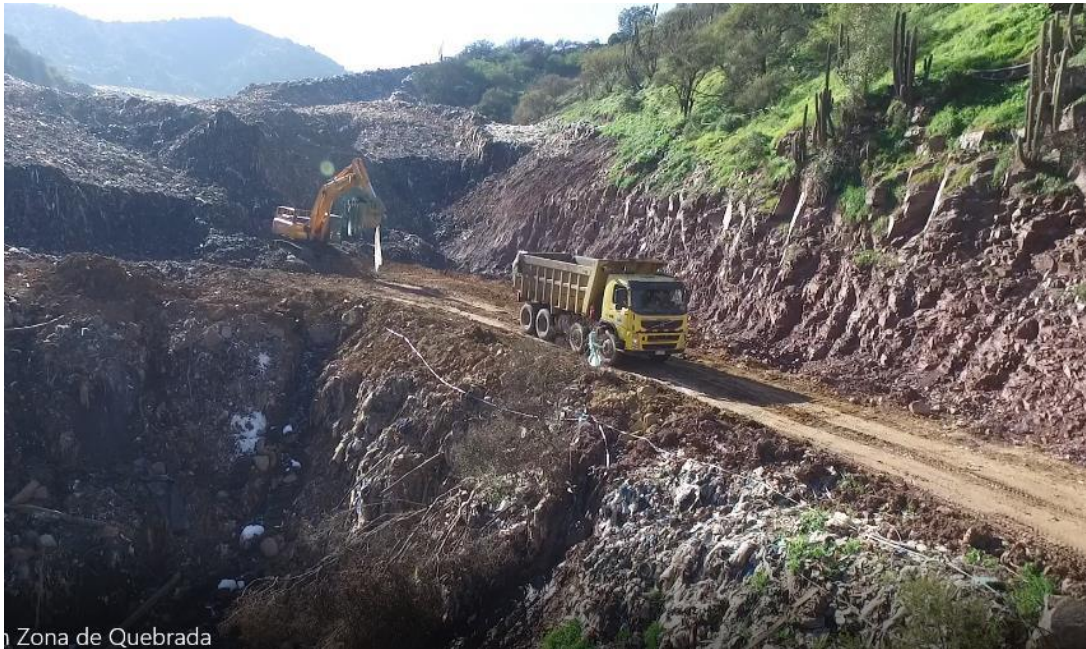
Fotografía 6 – Carguío a Camión Tolva en Sector Bajo de la Quebrada El Boldal (Sector 2).
