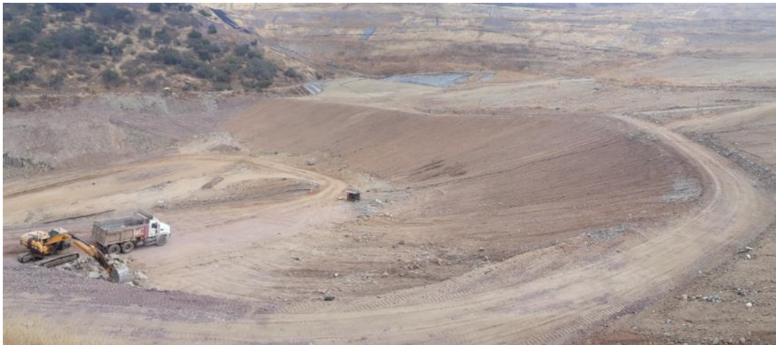
Fotografía 8 – Vista General Zona Consolidada del Sector.
