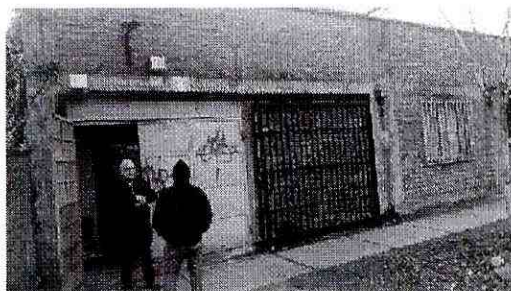
Fig. 2: Punto receptor 1 (exterior vivienda).
