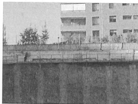
Implementación Panel acústico en muro perimetral
