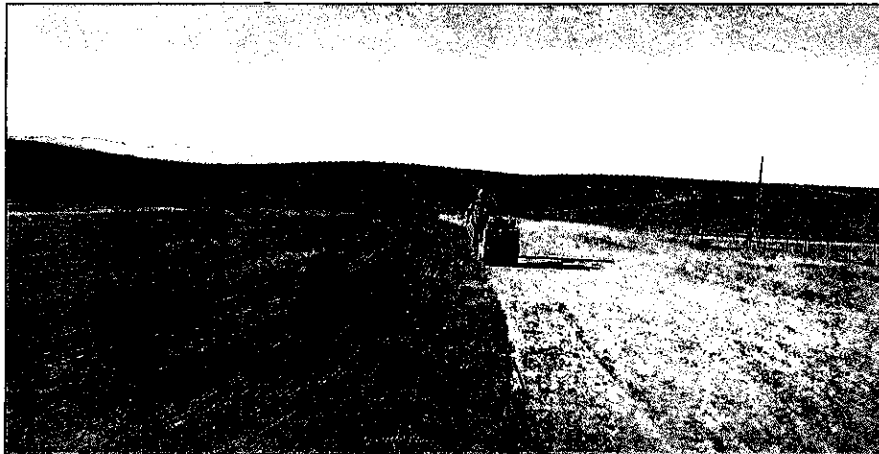
Imagen 15: Compactación de cobertura intermedia en el coronamiento
