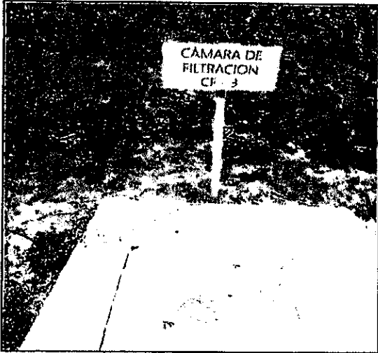
Fotografías 14 y 15: Cámara de Filtración 3:
