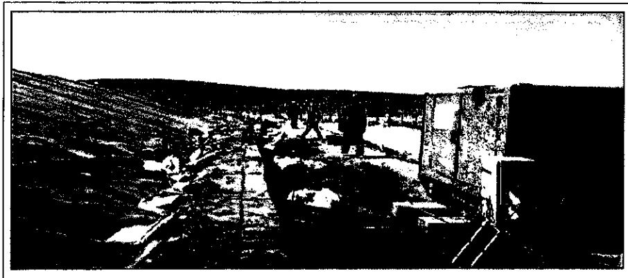
Imagen 22 y 23: Instalación Sistema de Impermeabilización de Geonet e = 5mm
