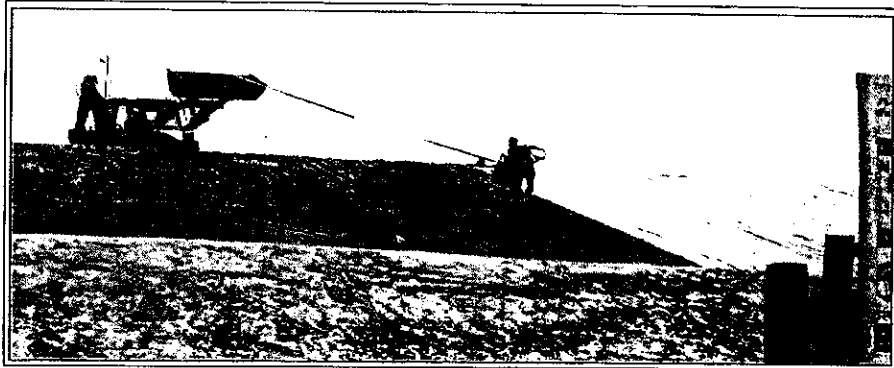
Imagen 17: Instalación Sistema de Impermeabilización lámina Bentonita GCL K = 5 \times 10^{-11} m/s
