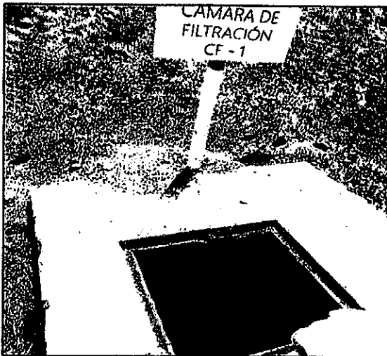
Fotografías 10 y 11: Cámara de Filtración 1
