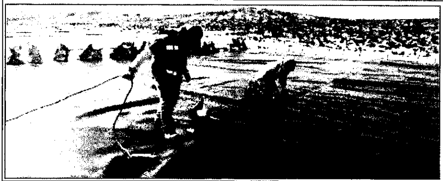
Imagen 21: Soldadura geomembrana basal con superficial por extrusión
