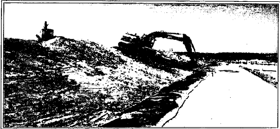
Imagen 15: Compactación de cobertura intermedia en el coronamiento
