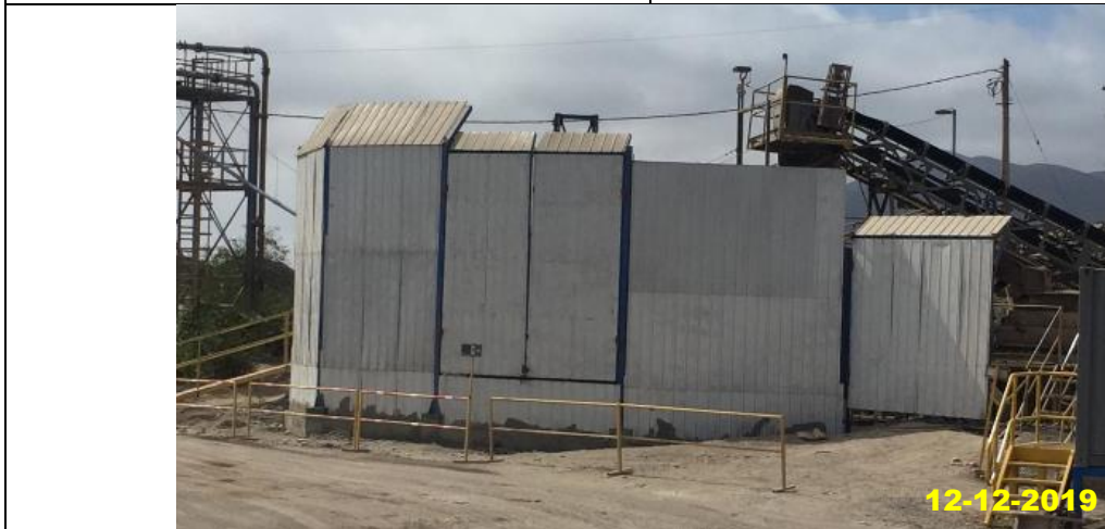
Foto 3 DESPUÉS. Vista SurOriente, con el detalle de la barrera acústica instalada para el Harnero 1 y el Chancador de Cono. Fecha 12-12-2019. Coordenadas UTM: N 6.688.192, E 290.593, H19, DATUM WGS 84.
