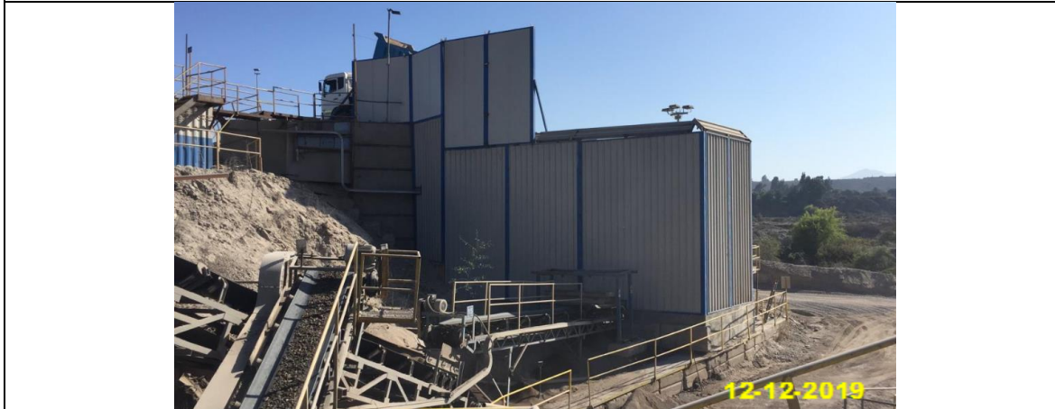
Foto 5 DESPUÉS. Detalle de instalación de la barrera acústica en chancador de mandíbula y descarga de camiones en el buzón principal. Fecha 12-12-2019 Coordenadas UTM: N 6.688.224, E 290.571, H19, DATUM WGS 84.
