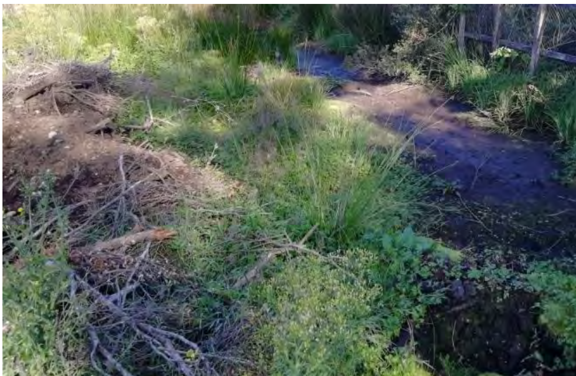
Fig. 10. Acumulación de tierra y remoción de árboles de rivera que llegan al trayecto del cauce que pasa por el interior del vertedero municipal al lado norte (Fotografía tomada el 07/02/2020).
