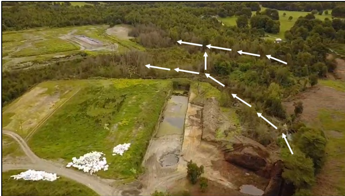
Fig. 6: Trayectoria de los cauces aguas abajo hacia ambas zonas de empozamientos. Fotografía tomada el 20/12/2019.
