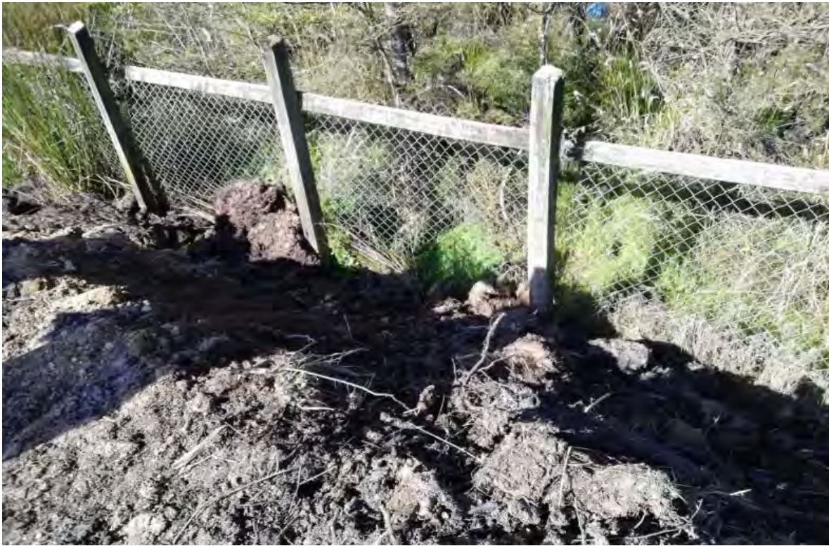
Fig. 11. Acumulación de tierra y remoción de árboles de rivera por el lado oeste del vertedero municipal. Se observan ramas y raíces removidas. (Fotografía tomada el 07/02/2020).
