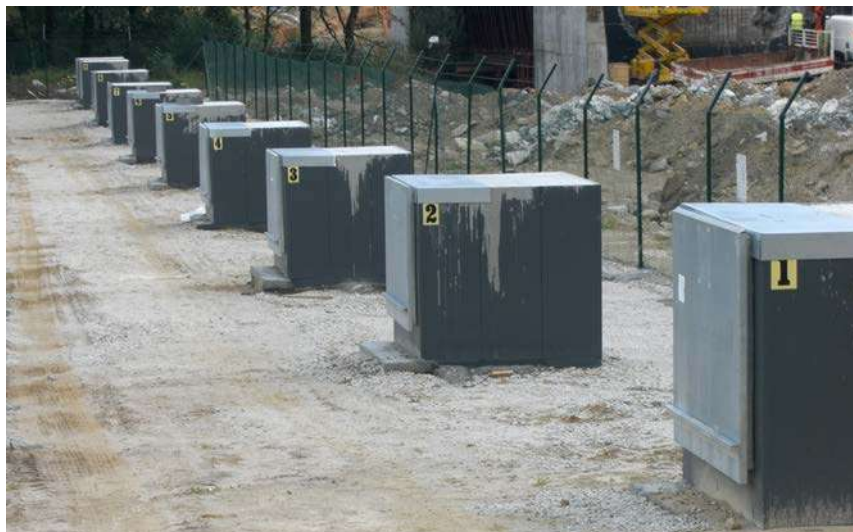
Figura 137: Instalación de polvorines en obra (Ferrimax)
