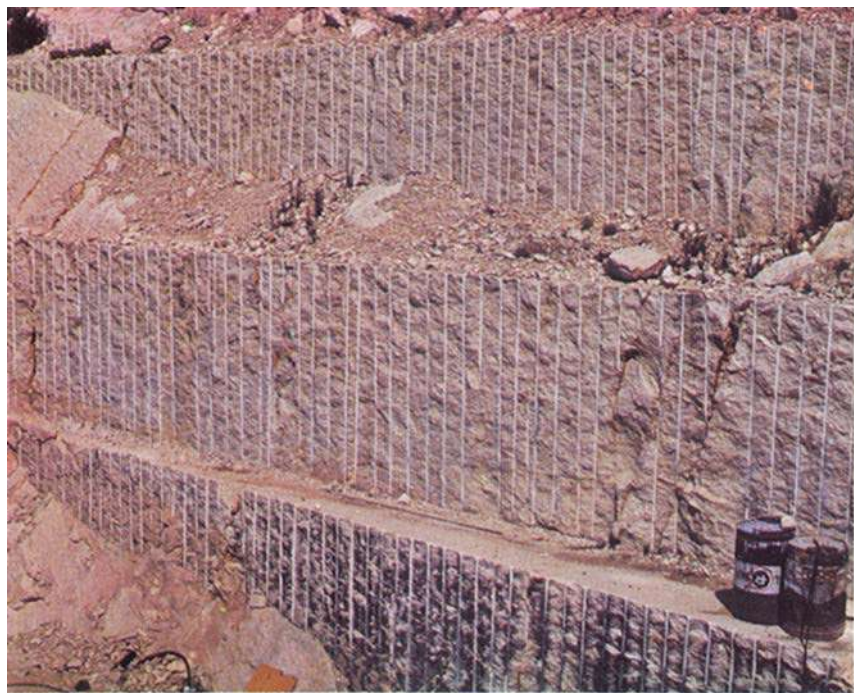
Figura 96: Resultado de una voladura de contorno
