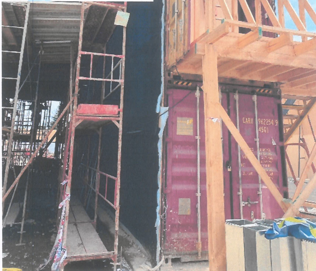
Proceso de construcción de tune acústico. Vista interior oriente
