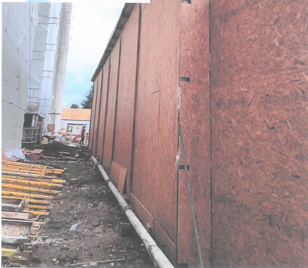
Túnel acústico vista poniente exterior
