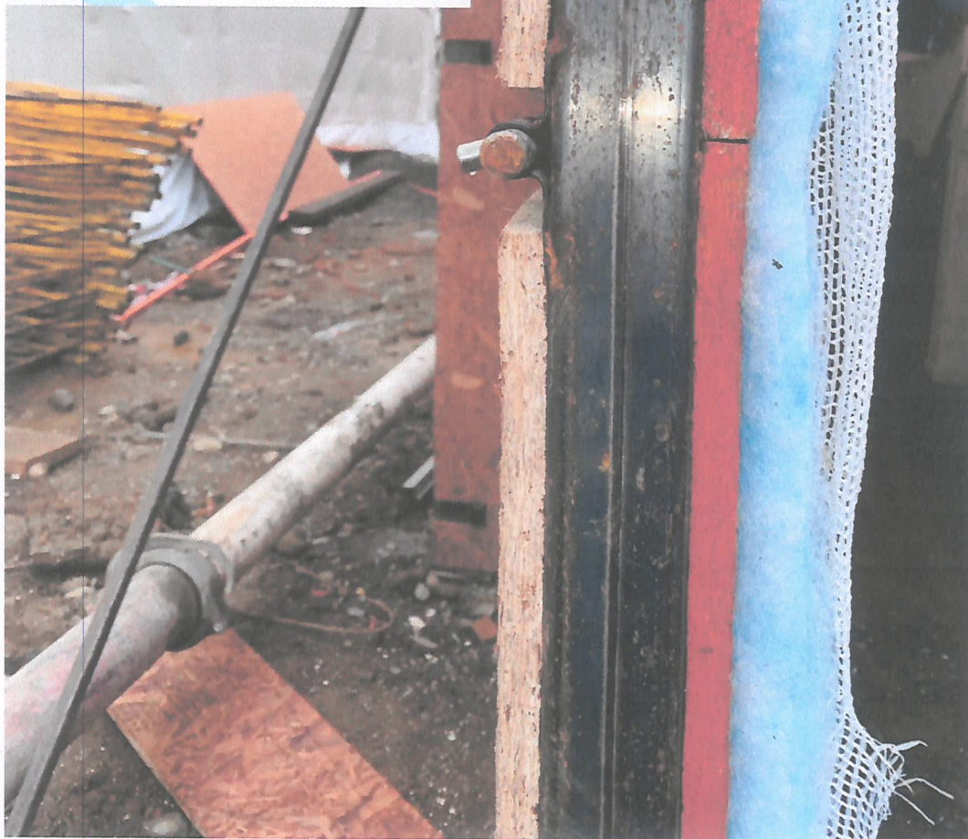
Detalle de Puerta de Túnel Acústico
