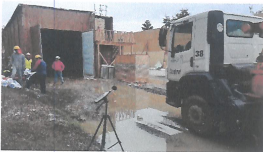
Figura 5. Medición realizada con fuente de ruido al exterior del túnel acústico.
