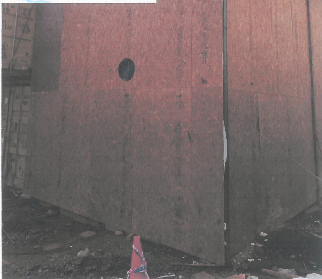
Túnel acústico lado Nor-poniente exterior
