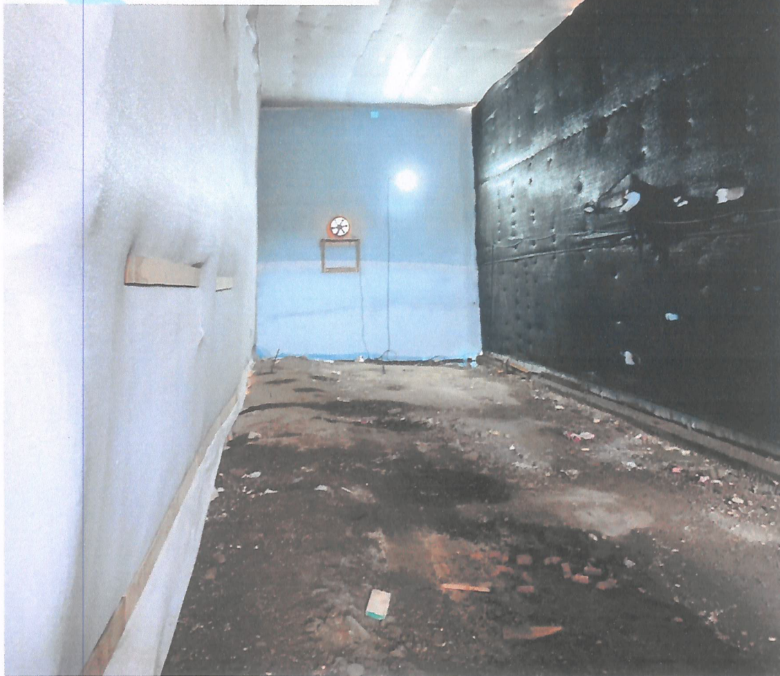
Interior de Túnel acústico
