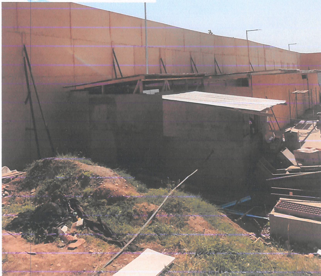
Instalación pantalla acústica perimetral sector Norte terminada.
