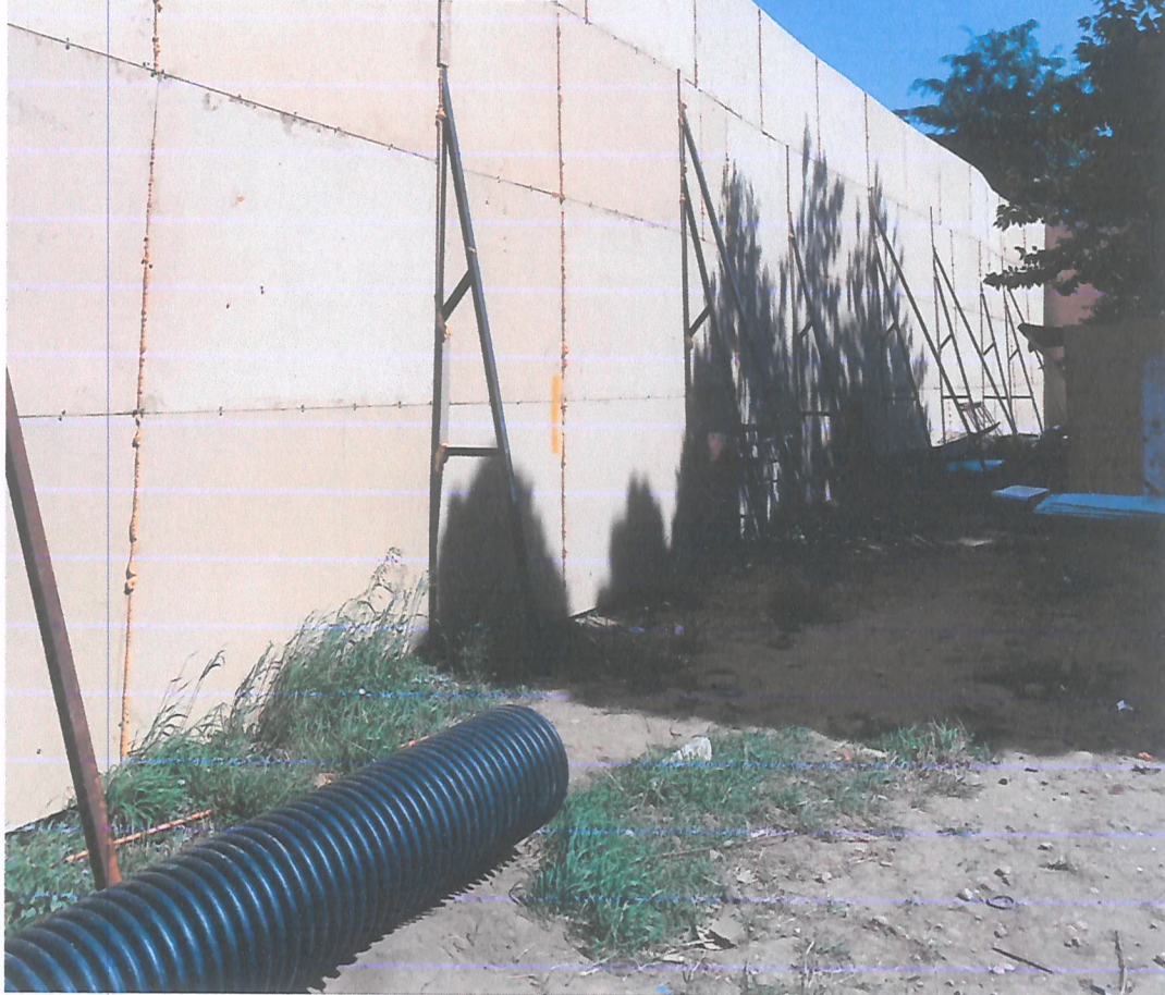
Instalación pantalla acústica perimetral sector Poniente terminada.
