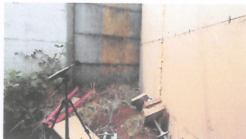
Figura 5. Medición realizada a 2 m de fuente de ruido con pantalla acústica perimetral.
