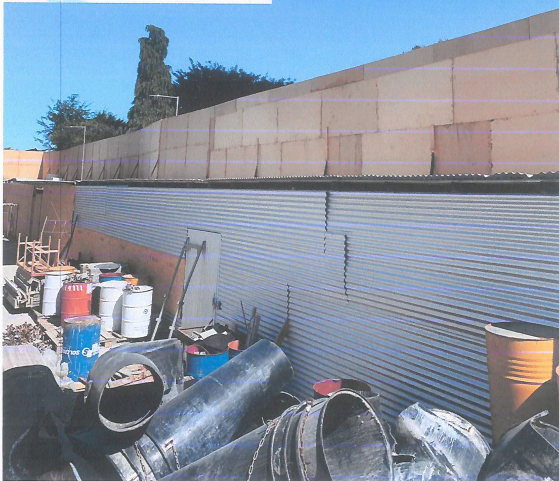
Instalación pantalla acústica perimetral sector Norte terminada.
