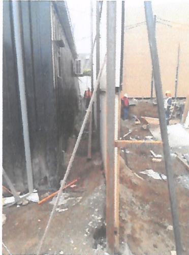
Figura 6. Medición realizada a 2 m de fuente de ruido con pantalla acústica perimetral.
