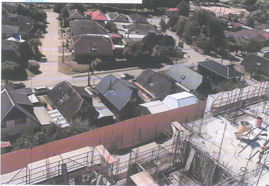
Instalación pantalla acústica perimetral sector Oriente terminada.
