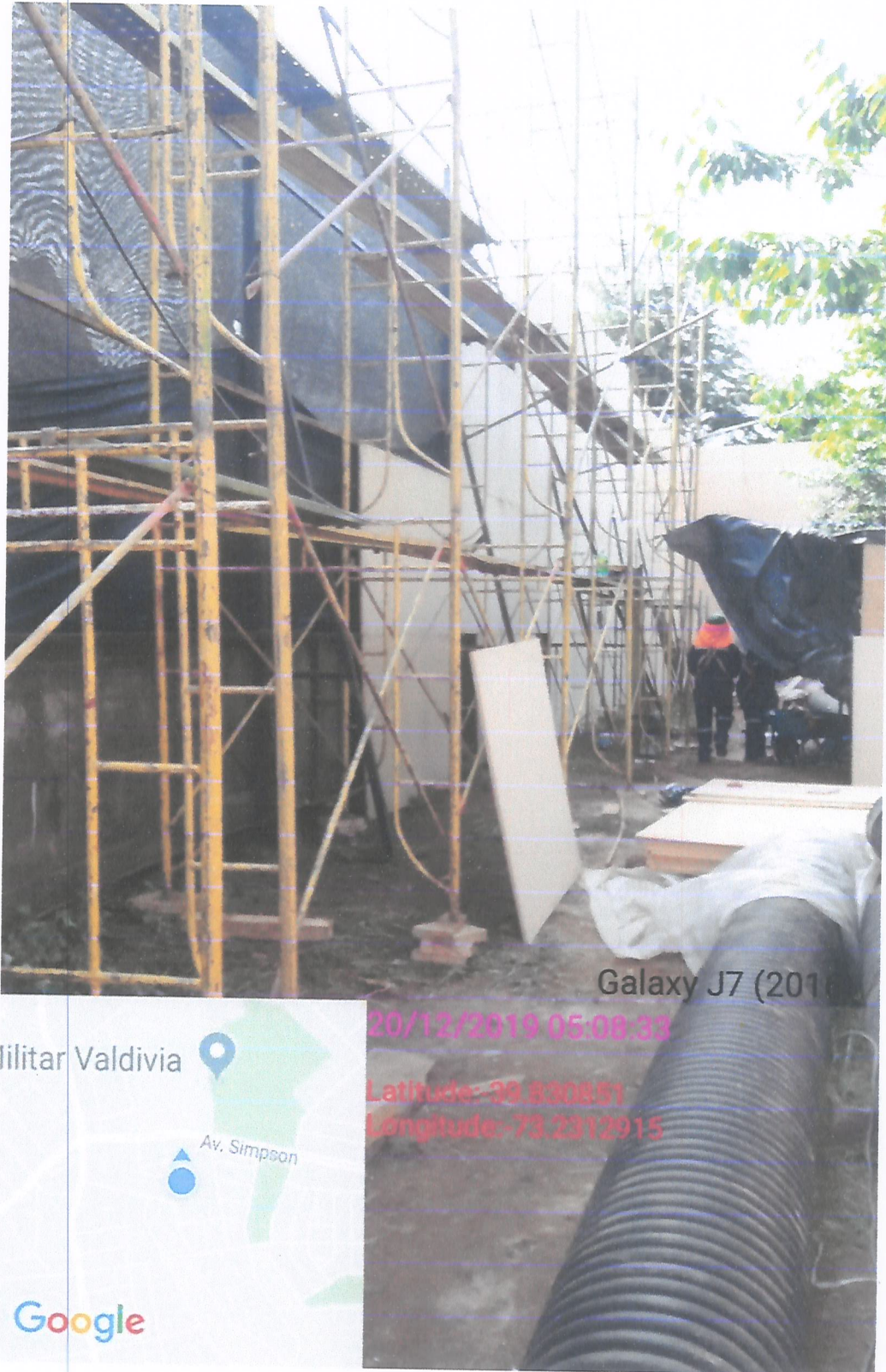
Instalación pantalla acústica perimetral sector Poniente en proceso.
