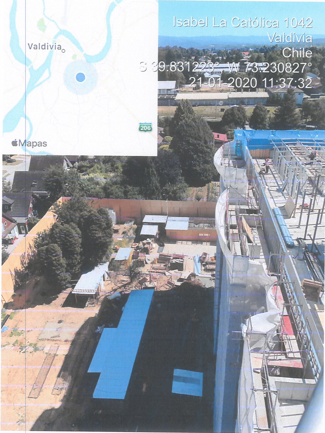
Instalación pantalla acústica perimetral sector Norponiente terminada.
