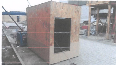
Figura 6. Encierro acústico para placa compactadora
