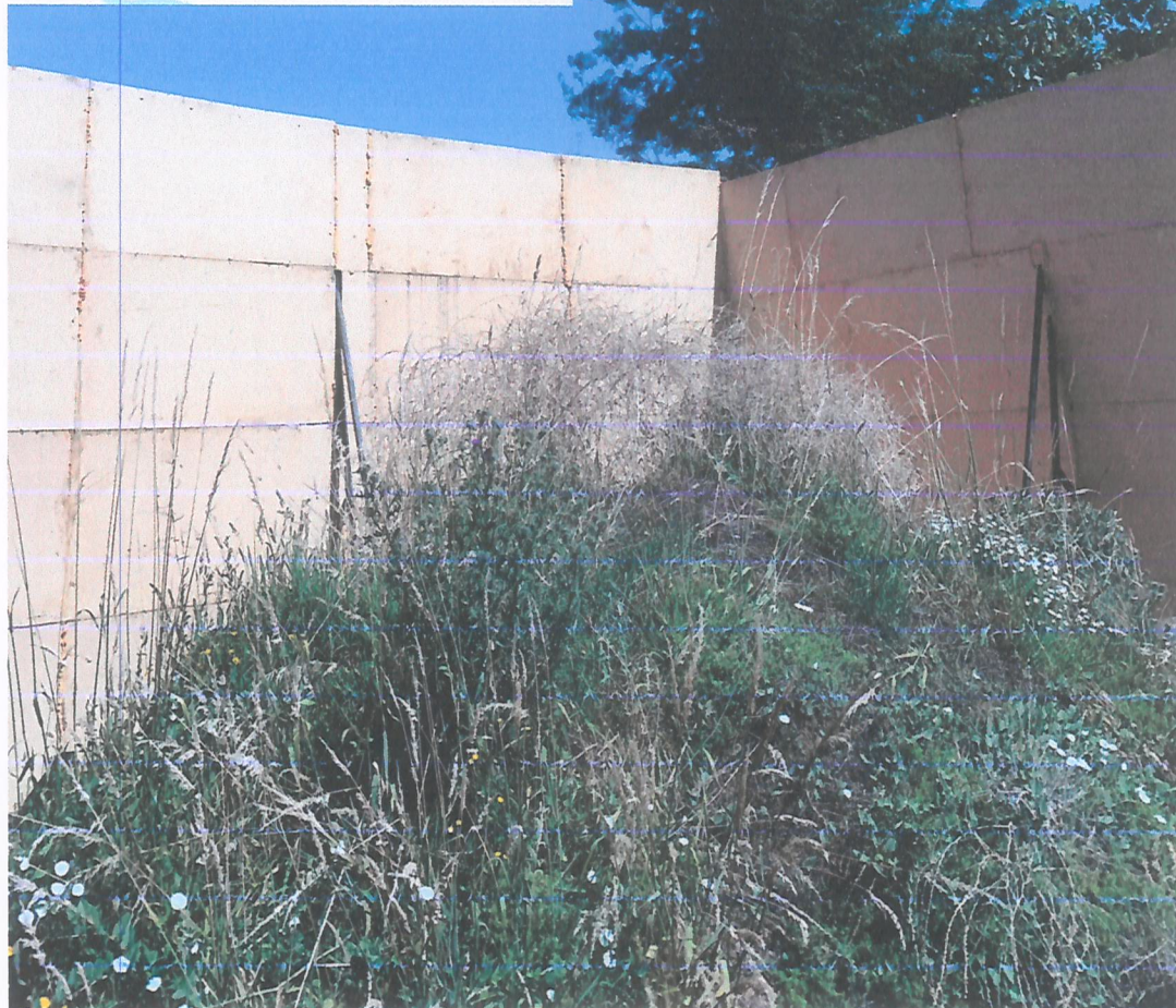
Instalación pantalla acústica perimetral esquina Norponiente terminada.
