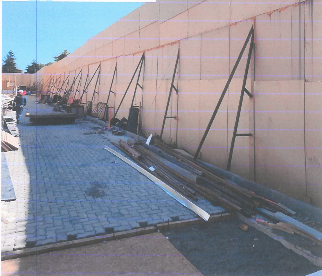
Instalación pantalla acústica perimetral sector Oriente terminada.
