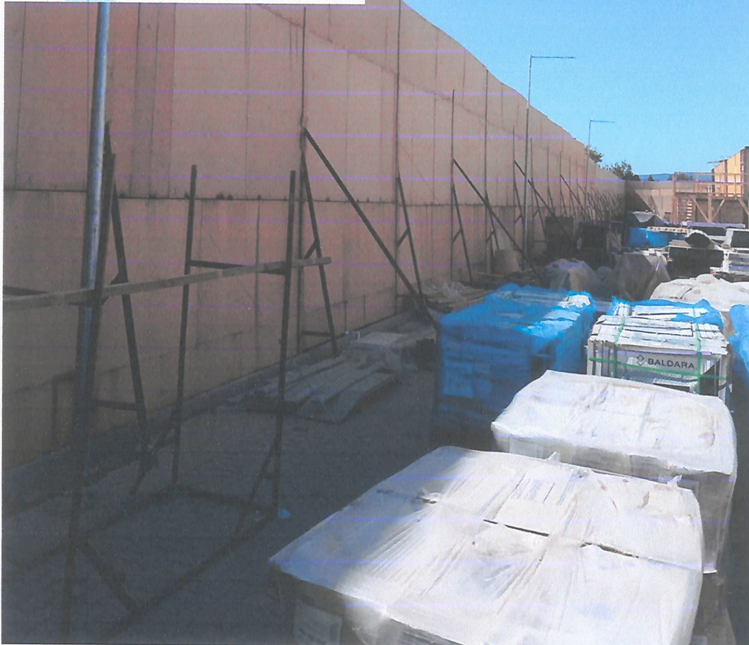
Instalación pantalla acústica perimetral sector Oriente terminada.
