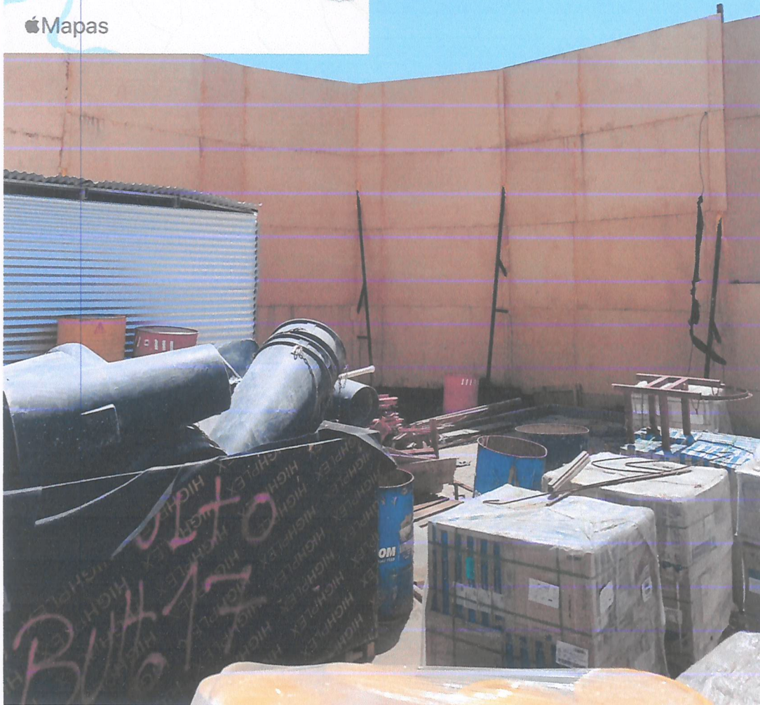
Instalación pantalla acústica perimetral esquina Nororiente terminada.
