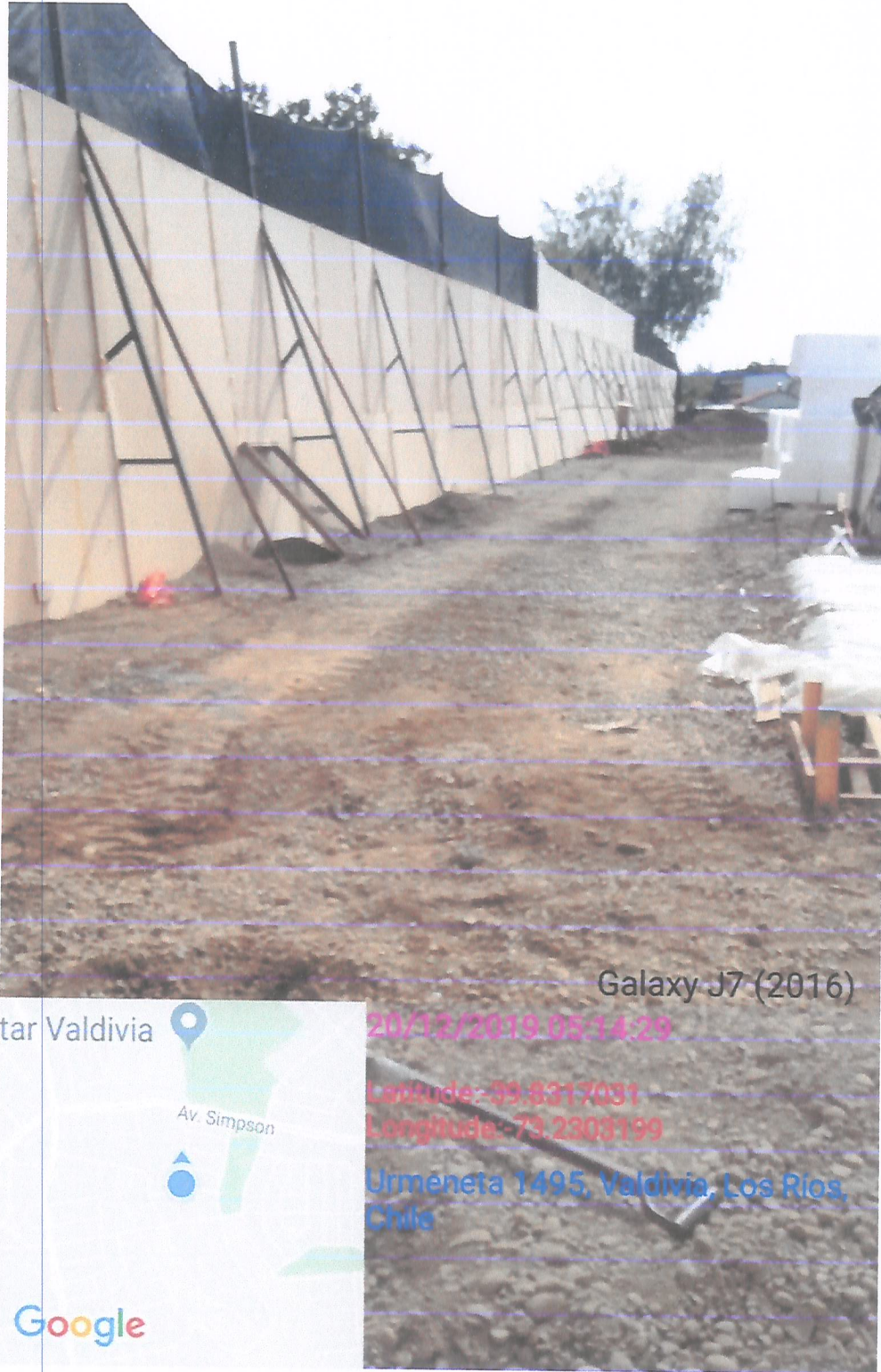
Instalación pantalla acústica perimetral sector Sur en proceso.
