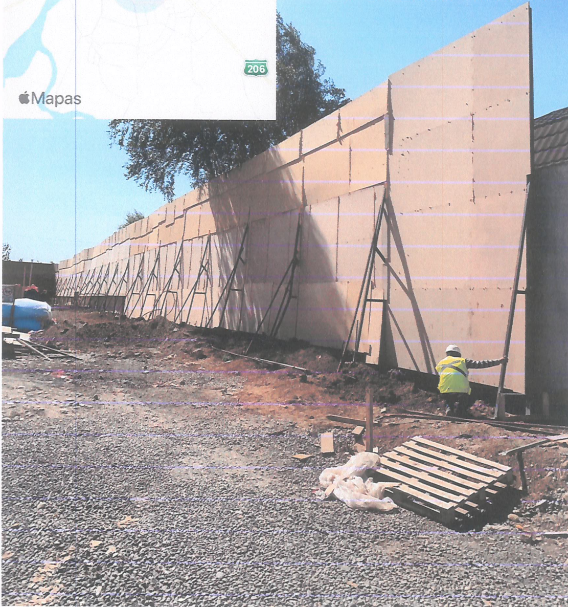
Instalación pantalla acústica perimetral sector Sur terminada.
