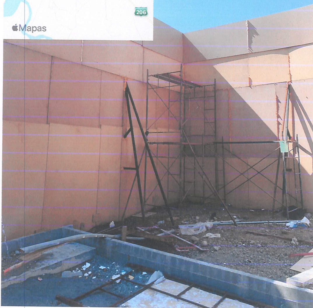
Instalación pantalla acústica perimetral sector esquina Suroriente terminada.
