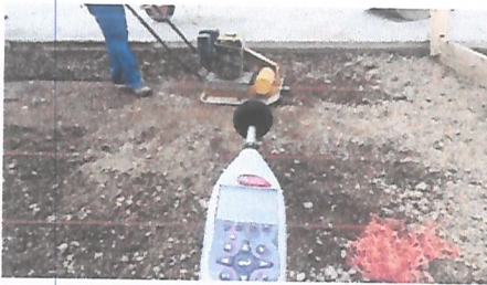
Figura 24. Medición realizada a 2 m de fuente de ruido sin pantalla acústica perimetral.
