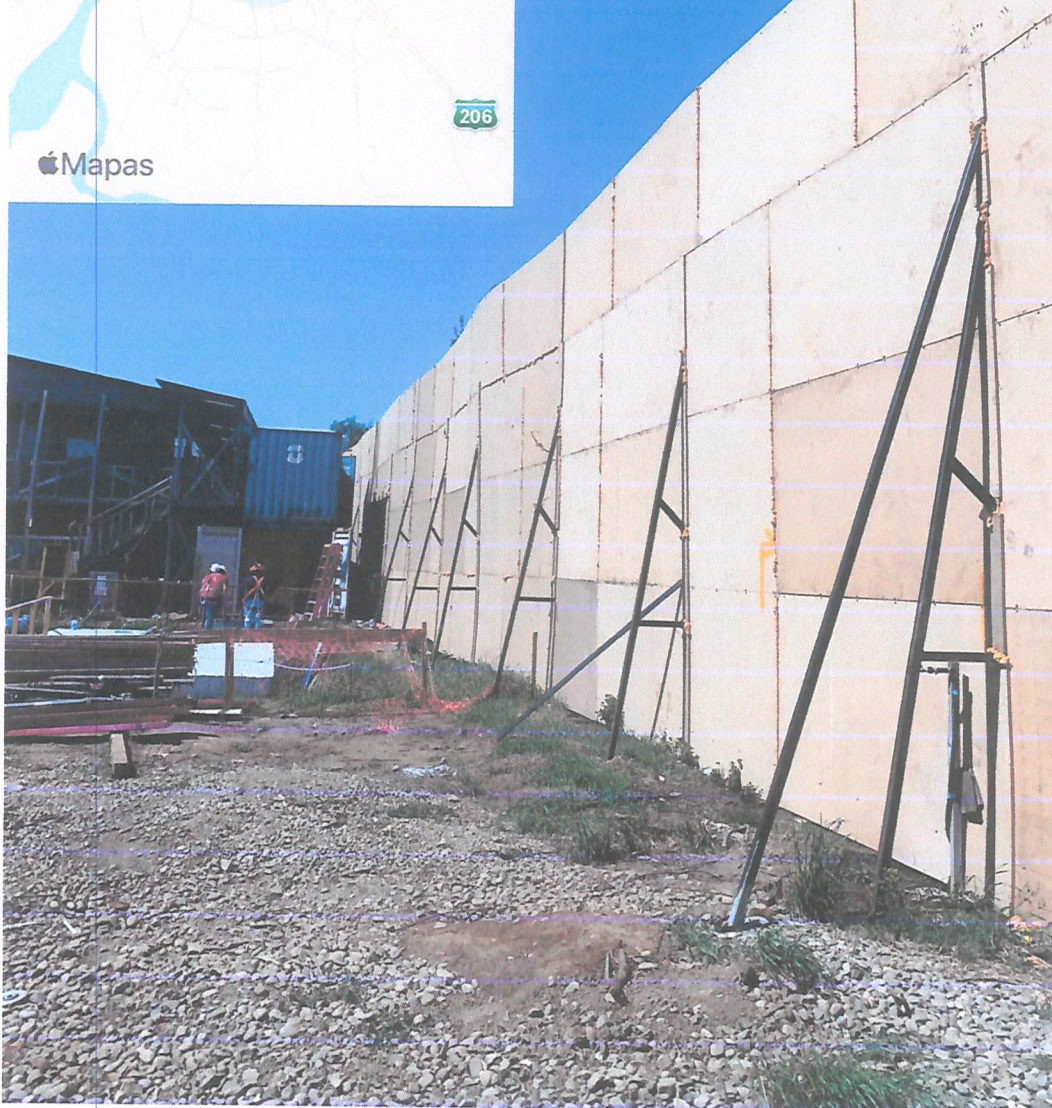
Instalación pantalla acústica perimetral sector Poniente terminada.
