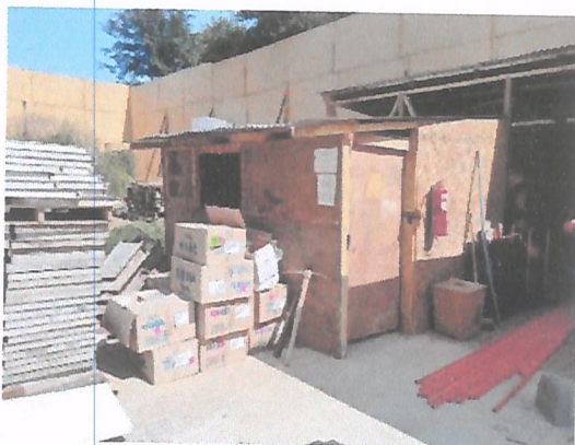
Cierre acústico taller de soldadura
