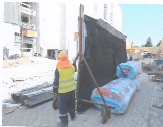
Pantalla acústica móvil al interior de obra
