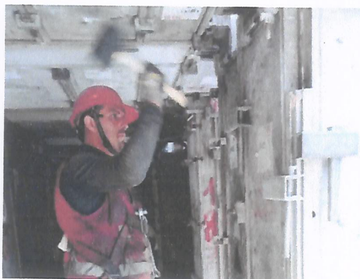
Golpes de martillo de goma en altura, en moldajes de concreto en torre B
