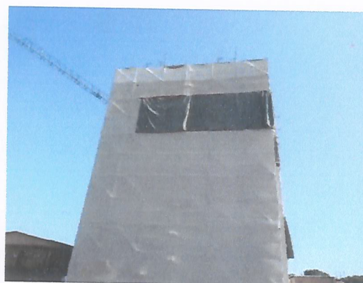
Pantallas acústicas flexibles adosadas en zonas de trabajo al interior de torres
